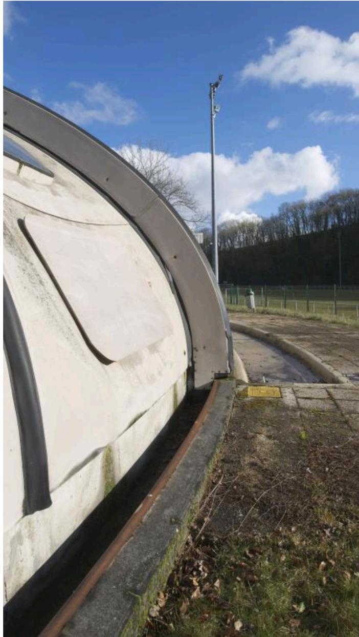
Vue de détail sur le rail permettant à la partie mobile de coulisser.
