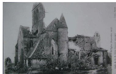
Ancienne église en ruines pendant les conflits (coll. part.). Phot. Inès Guérin IVR22_20050200682NUCAB
