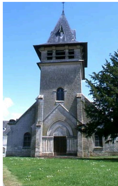
Vue de la façade ouest. Phot. Inès Guérin IVR22_20030203199NUCA
