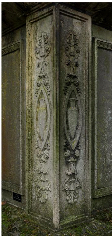
Vue de détail d'un pilastre de la partie inférieure du cippe. Phot. Marie-Laure Monnehay-Vulliet IVR22_20138000598NUC2A
