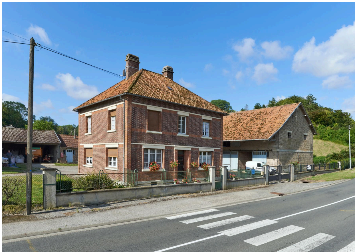
Exemple d'une ferme de la Seconde Reconstruction. Ferme Fourdrinier, 10 route d'Abbeville. Vue prise depuis le nord.
