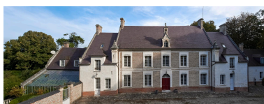
Château de Vieulaines, vue prise depuis le sud. Phot. Thierry Lefébure IVR32_20238000492NUCA
