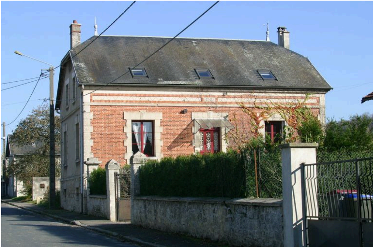
Vue générale de la façade principale.
