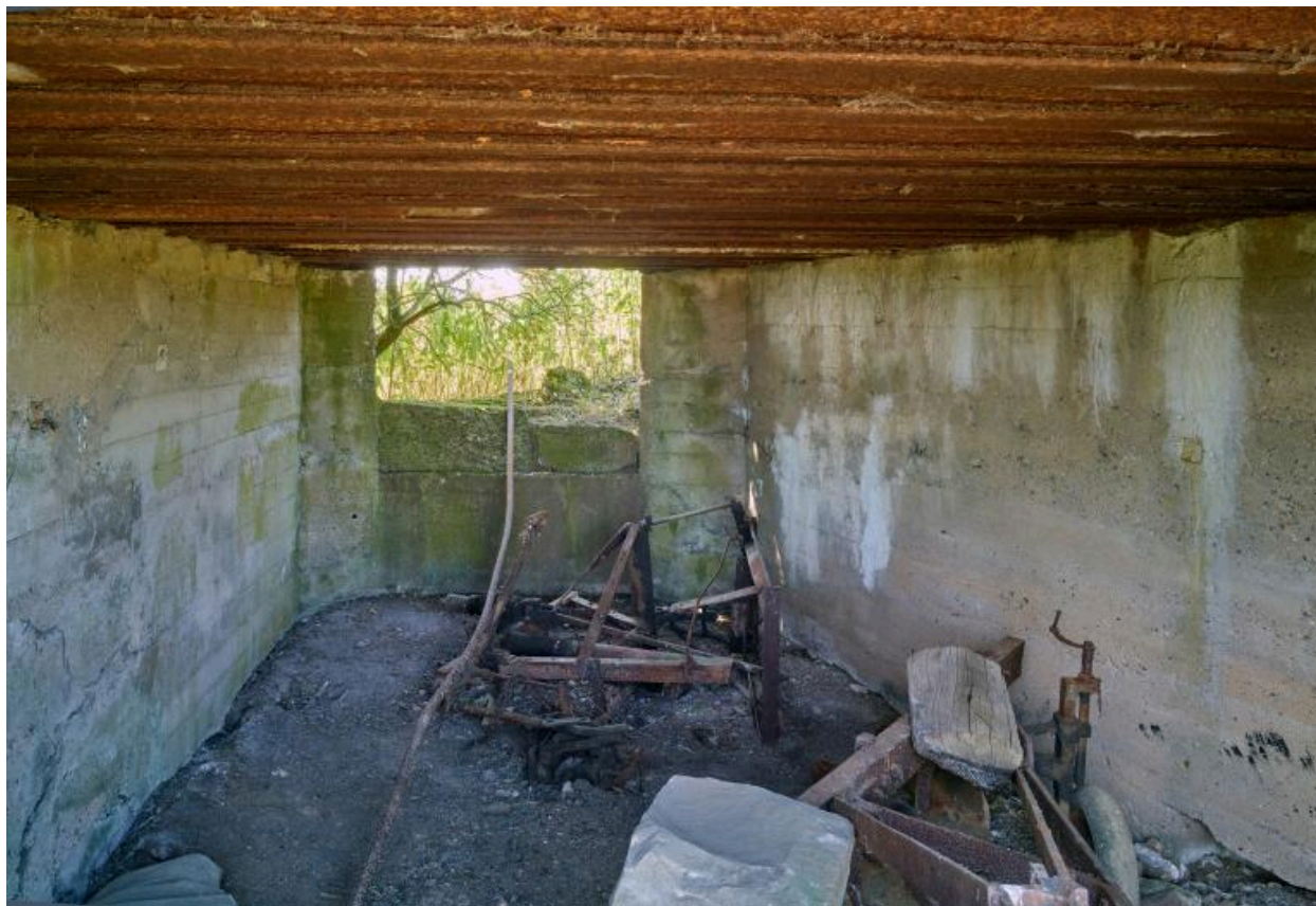
Vue longitudinale de la chambre de tir.
