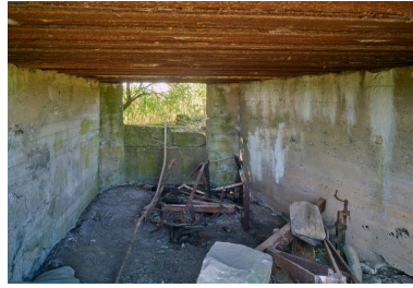
Vue longitudinale de la chambre de tir. Phot. Pierre Thibaut IVR32_20185900547NUCA
