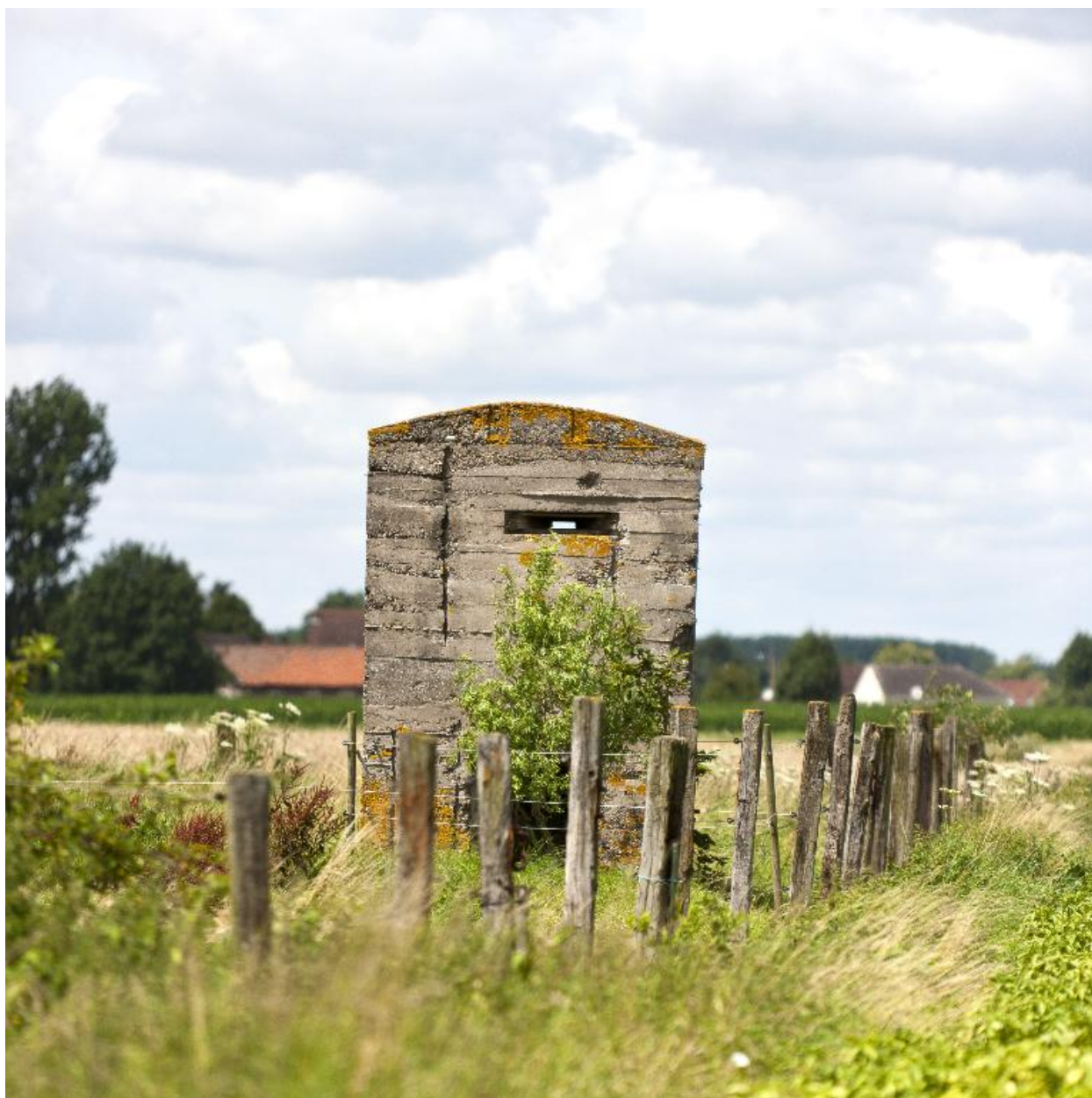
Vue générale vers le nord-ouest
