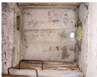
Vue intérieure zénithale Phot. Pierre Thibaut IVR32_20165900569NUCA
