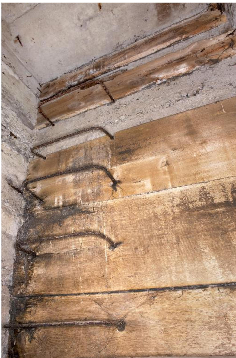
Vue intérieure : échelons métalliques et coffrage
