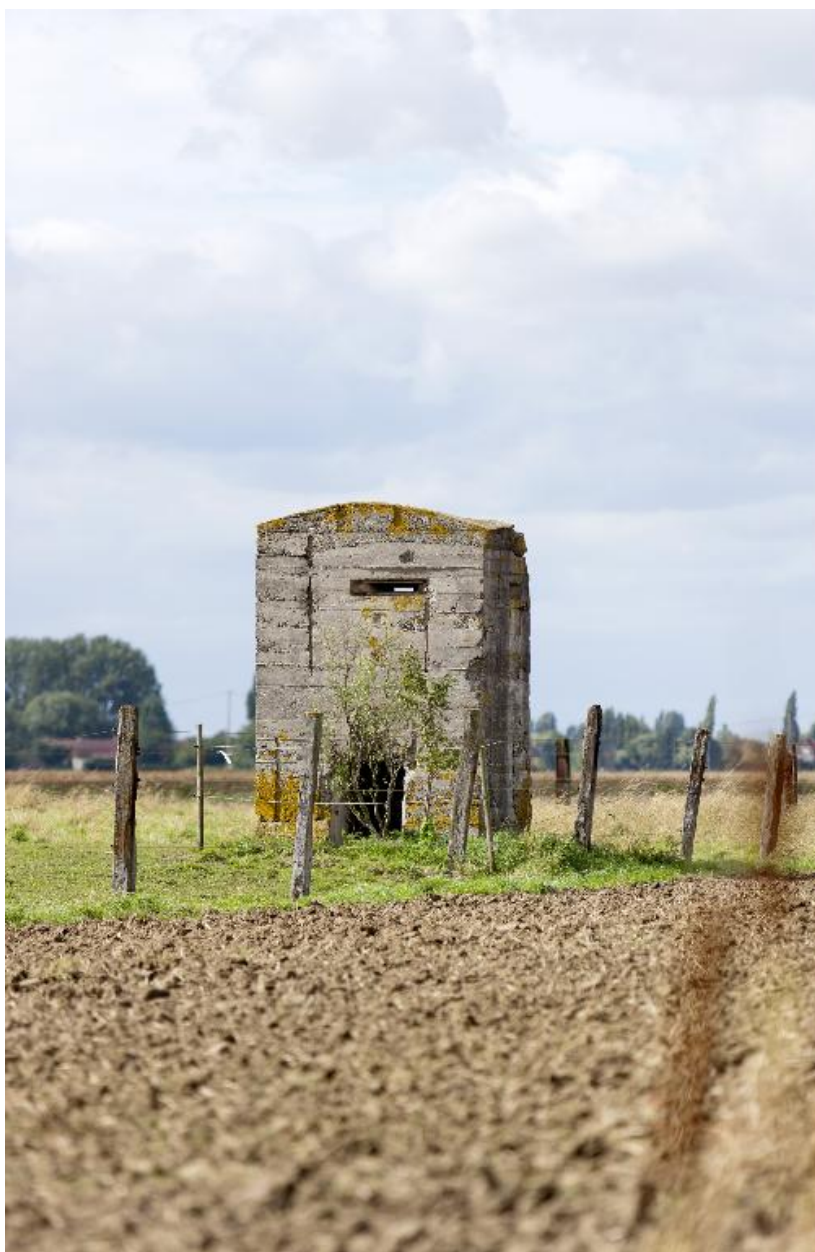
Vue générale vers le nord-ouest
