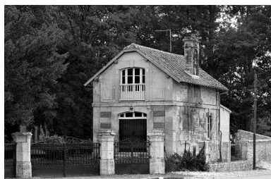
La conciergerie, vue depuis le nord. Phot. Thierry Lefébure IVR22_19900201992X
