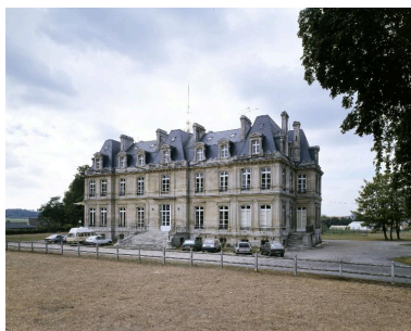
Vue de la façade orientale. Phot. Thierry Lefébure IVR22_19900202424VA
