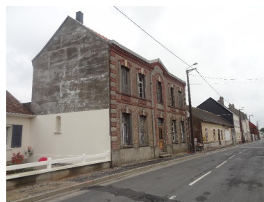
Vue d'ensemble depuis la rue Isaïe-Sellier. Phot. Frédéric-Nicolas Kocourek IVR22_20158006265NUCA
