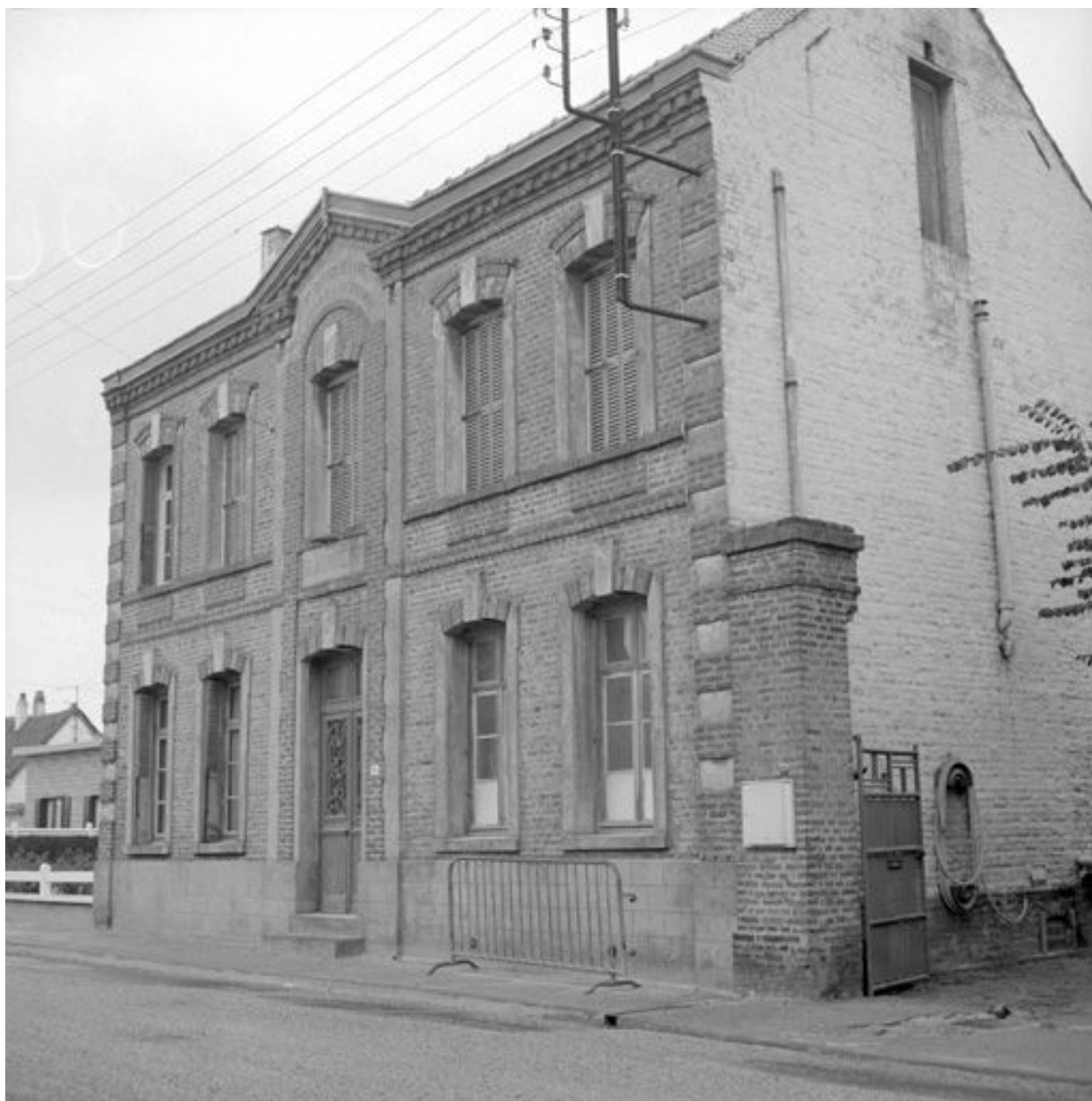
Logement patronal, élévation antérieure.
