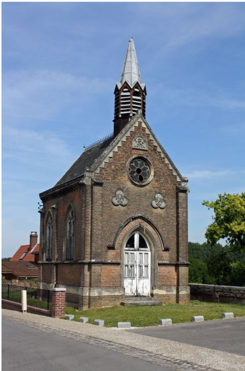
Ville-le-Marlet, chapelle Saint-Lambert, Jean Herbault architecte (?), 1868.
