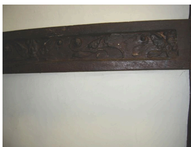
Détail d'une solive du 16e siècle. Phot. Inès Guérin IVR22_20058005734NUCA
