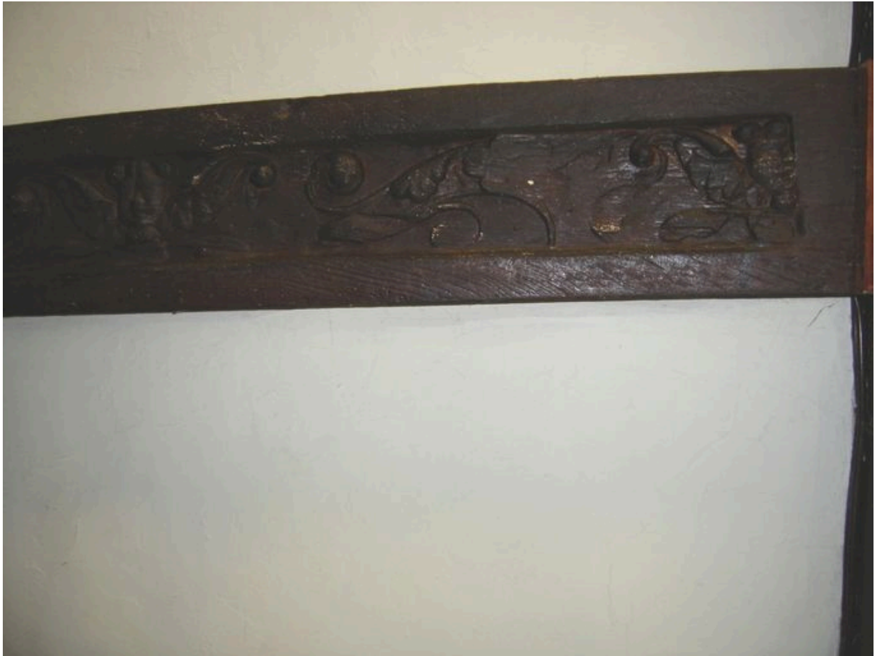
Détail d'une solive du 16e siècle.
