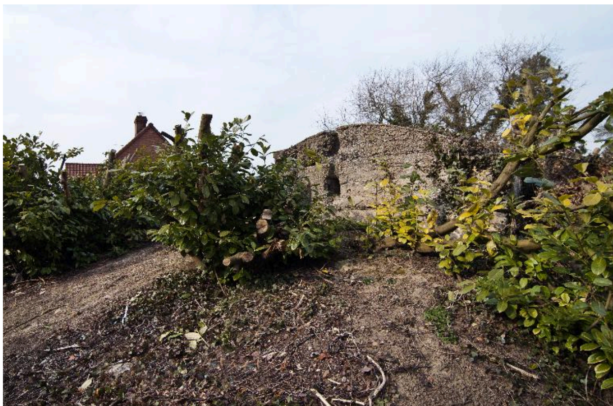
Elévation sud, détail (au grand angulaire)
