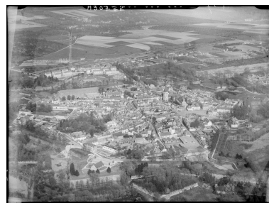
Vue aérienne de la ville réalisée en 1934 par l'IGN. La cheminée située à la jonction des deux ailes n'existe pas ou plus (IGN. Photothèque nationale. 1934). Repro. Pierre Thibaut, Phot. Institut Géographique National IVR32_20245902419NUCA
