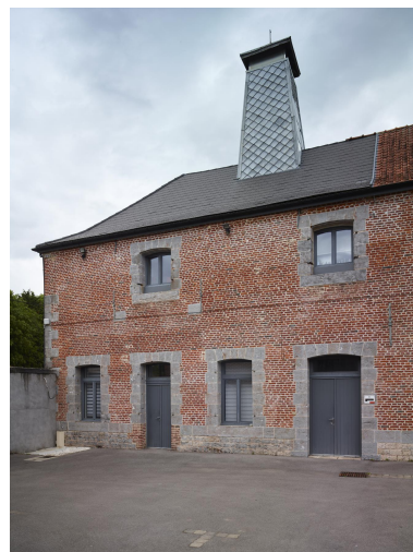
Ancienne boulangerie militaire : extrémité ouest de la façade sur cour. Phot. Pierre Thibaut IVR32_20245900179NUCA
