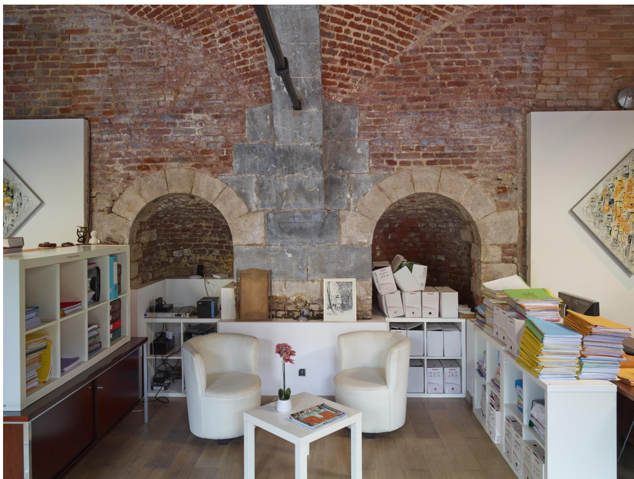
Ancienne boulangerie militaire : intérieur du bâtiment, détail de niches dans le mur nord du rez-de-chaussée.
