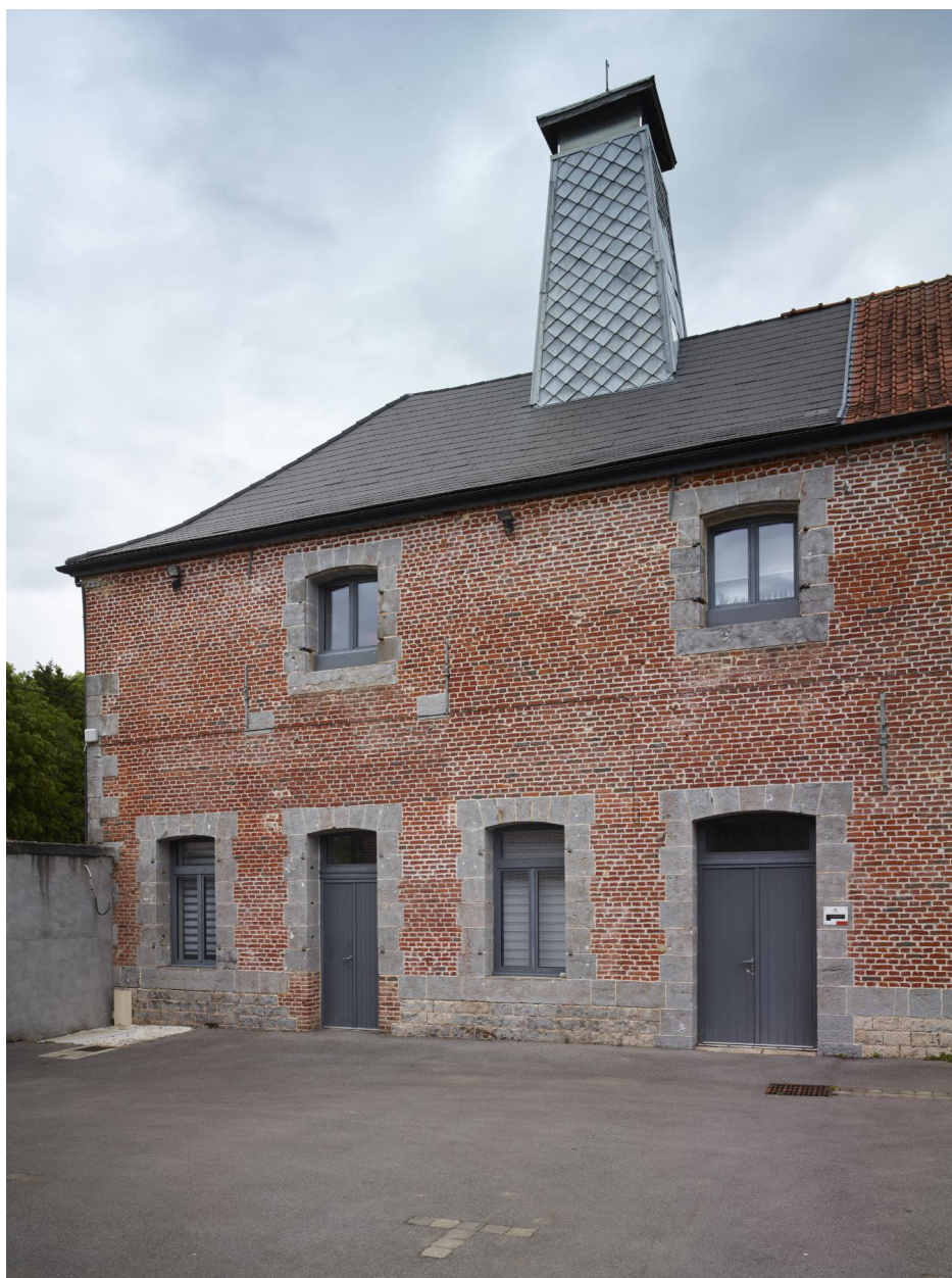
Ancienne boulangerie militaire : extrémité ouest de la façade sur cour.
