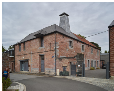
Ancienne boulangerie militaire : façade sur la rue de Turenne et façade sur cour. Phot. Pierre Thibaut IVR32_20245900180NUCA
