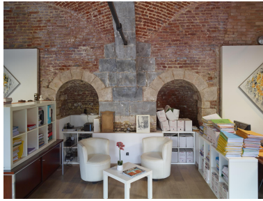
Ancienne boulangerie militaire : intérieur du bâtiment, détail de niches dans le mur nord du rez-de-chaussée.
