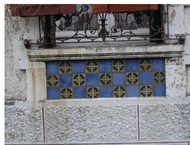
Vue détaillée des carreaux de céramique sous les baies. Phot. Inès Guérin IVR22_20068005163NUCA
