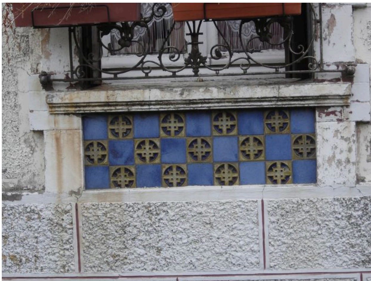
Vue détaillée des carreaux de céramique sous les baies.
