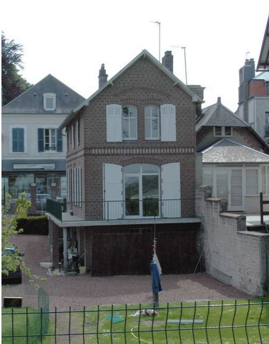
Elévation postérieure depuis le quai Amiral-Courbet.
