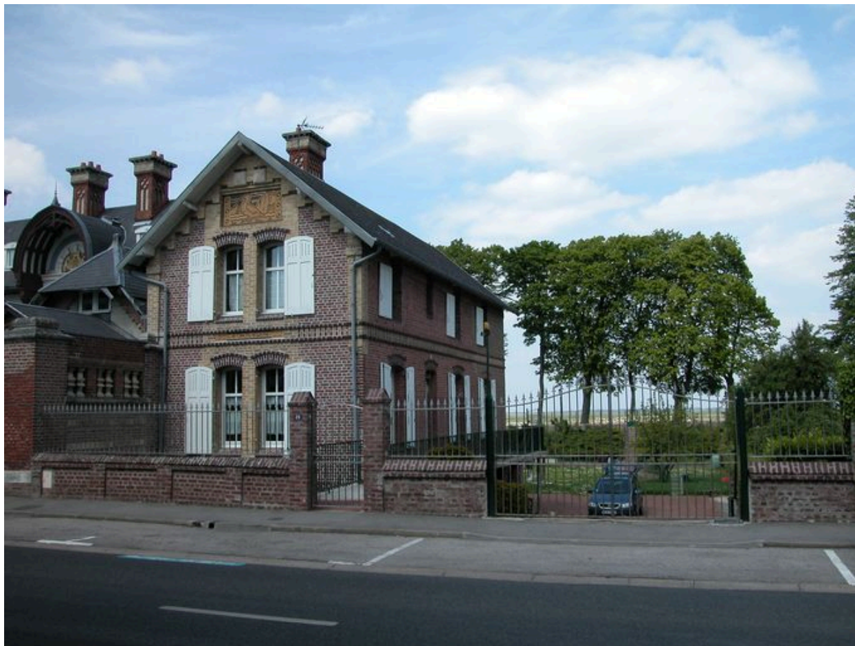
Vue d'ensemble depuis le quai du Romerel.
