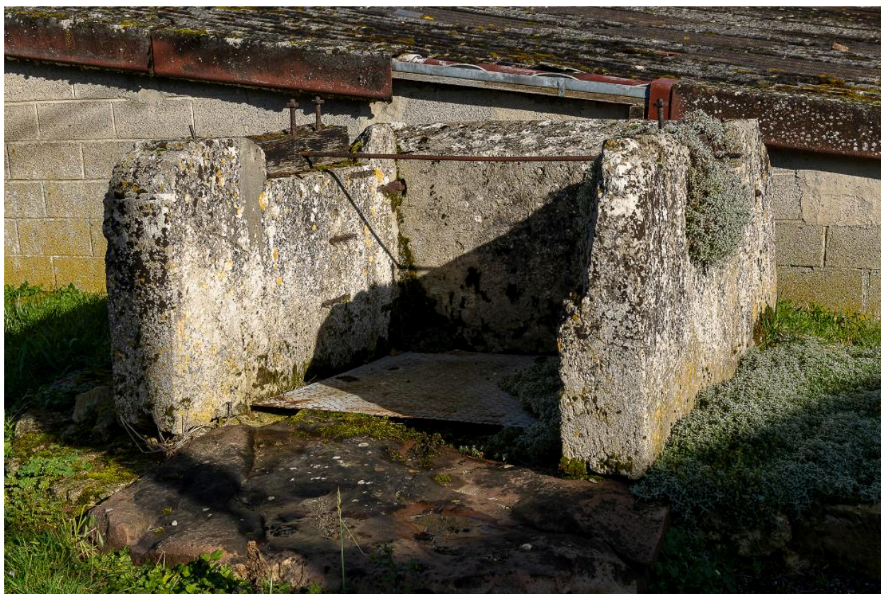
Anciens puits rue du Moulin.
