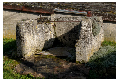
Anciens puits rue du Moulin. Phot. Marc Kérignard IVR32_20226000016NUCA
