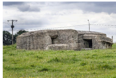
Vue vers le nord-est. Escalier d'entrée sur la partie gauche et toboggan pour la descente de caisses, sur la droite Phot. Jean-Marc Ramette IVR32_20175000353NUCA
