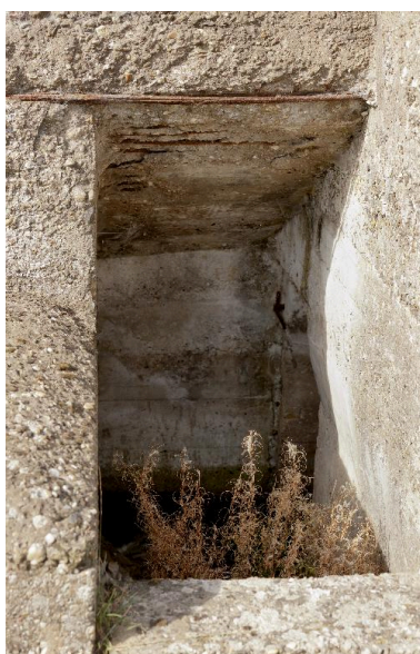
Escalier descendant dans l'abri Phot. Jean-Marc Ramette IVR31_20145904603NUCA
