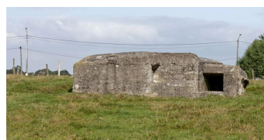
Vue vers le nord. En face l'ouverture du toboggan casematé Phot. Jean-Marc Ramette IVR31_20145904610NUCA
