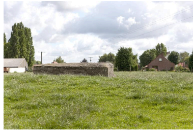
Vue vers l'est Phot. Jean-Marc Ramette IVR31_20145904605NUCA
