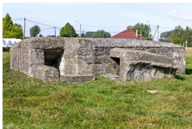
Vue vers le nord-ouest. Phot. Jean-Marc Ramette IVR31_20145904606NUCA
