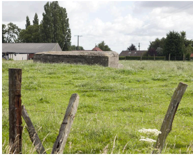
Vue vers l'est Phot. Jean-Marc Ramette IVR31_20145904600NUCA
