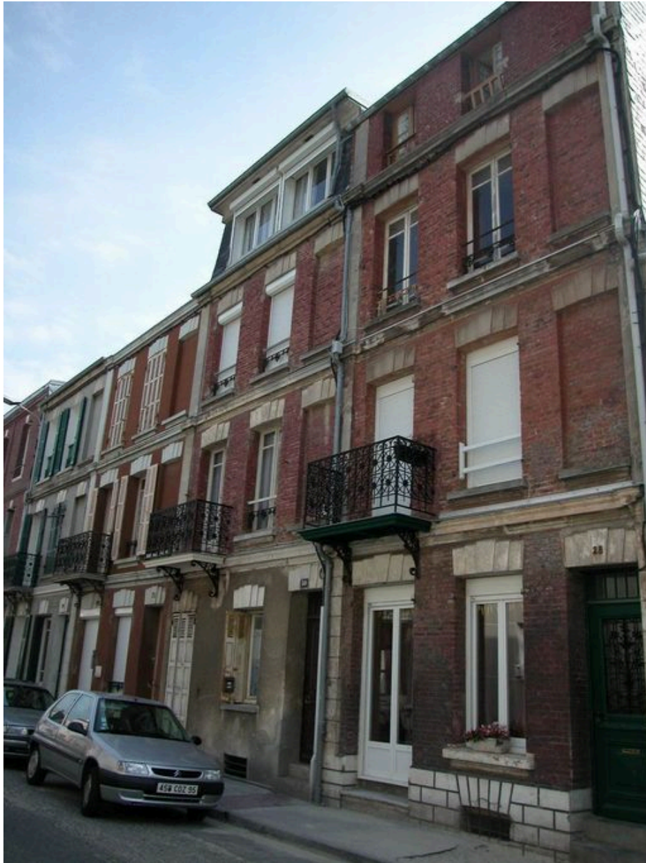
Vue d'ensemble des quatre logements.
