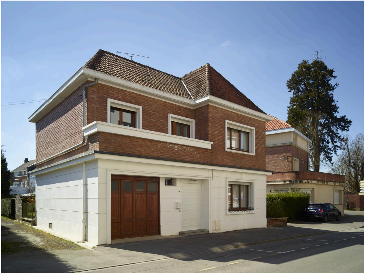
Vue de face de la façade principale et de la façade latérale gauche.
