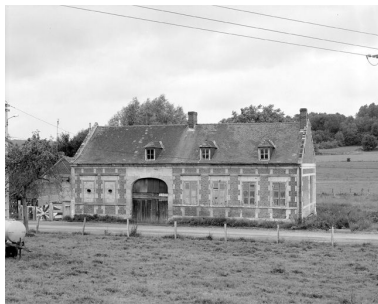
Logis. Vue d'ensemble. Phot. Jean-Michel Perrin IVR22_19856000993V
