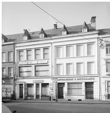
Maisons n° 38 et 34-36, vue générale (état en 2001).
