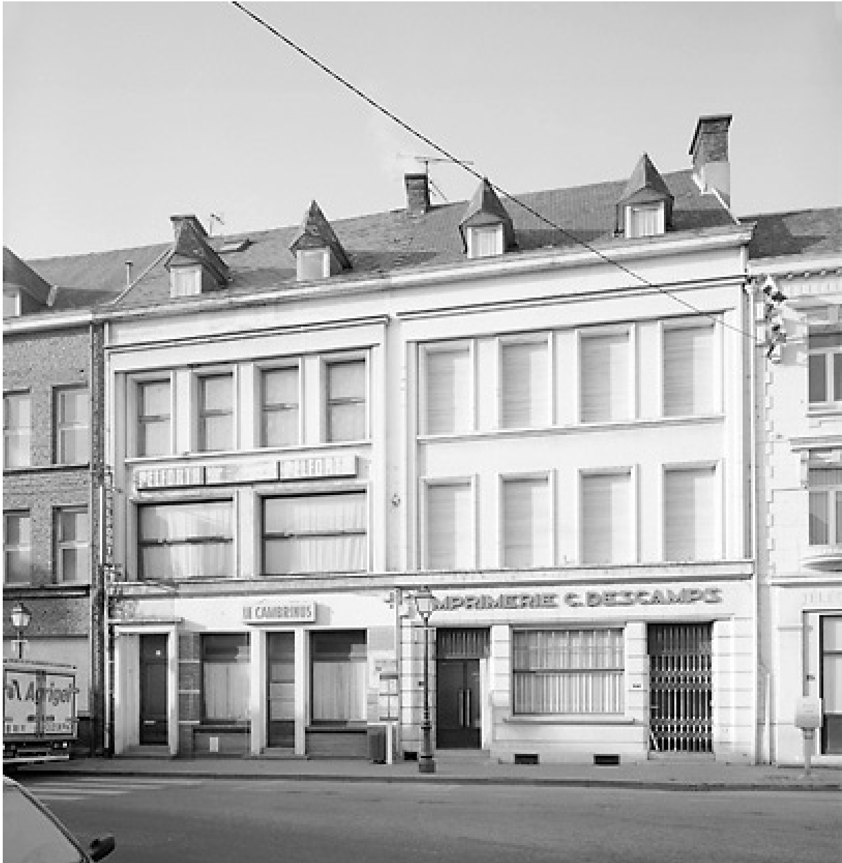
Maisons n° 38 et 34-36, vue générale (état en 2001).
