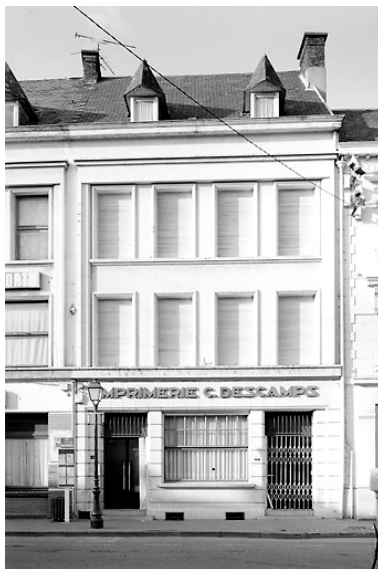
Maison n° 34-36, vue générale (état en 2001).
