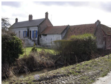
Vue générale de la ferme depuis le nord. Phot. Inès Guérin IVR22_20058005252NUCA
