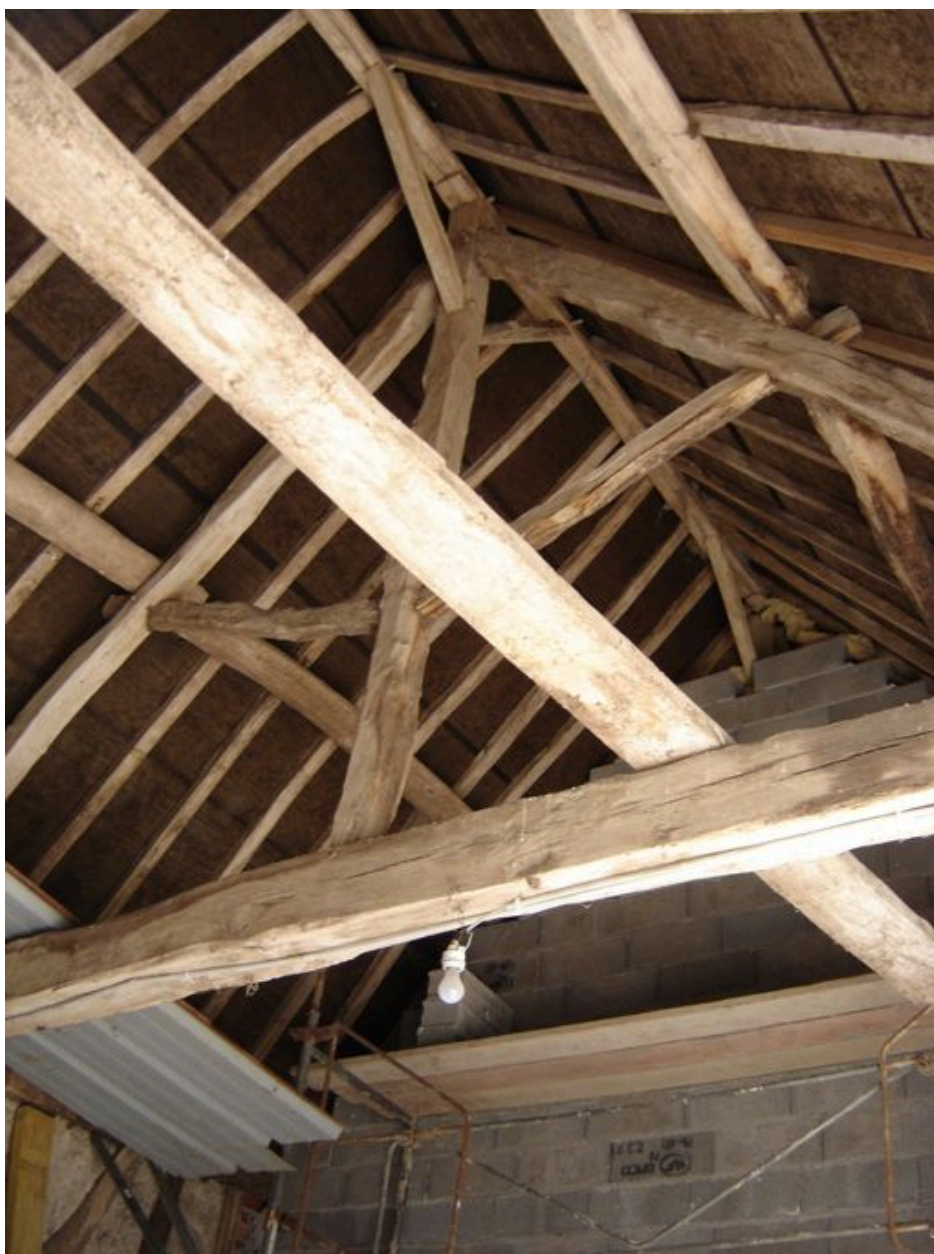
Vue détaillée de la charpente.
