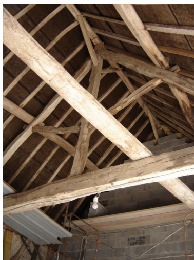
Vue détaillée de la charpente. Phot. Inès Guérin IVR22_20058005250NUCA
