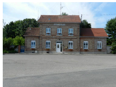
Vue générale. Phot. Romain Grimaud IVR22_20138016201NUCA
