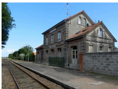
Vue depuis les voies. Phot. Romain Grimaud IVR22_20138016203NUCA
