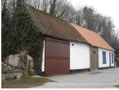
Vue générale. Phot. Inès Guérin IVR22_20058005002NUCA
