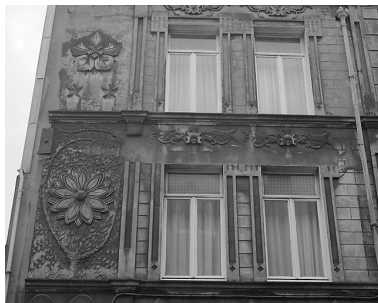
Façade sur voie, représentation. Phot. Philippe Caudroit IVR31_19846200233X
