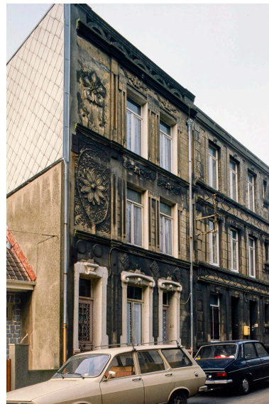
Vue d' angle sur voie. Phot. Philippe Caudroit IVR31_19826200187ZA
