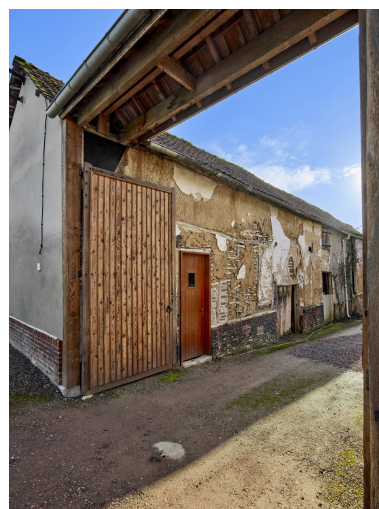
Vue de la grange, depuis le nord. Phot. Thierry Lefébure IVR32_20258000242NUCA
