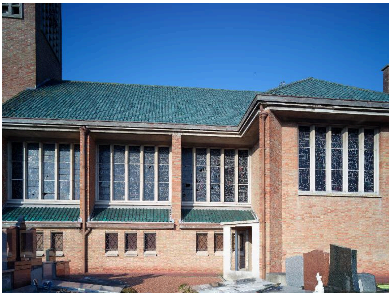
Vue extérieure des verrières côté droit
