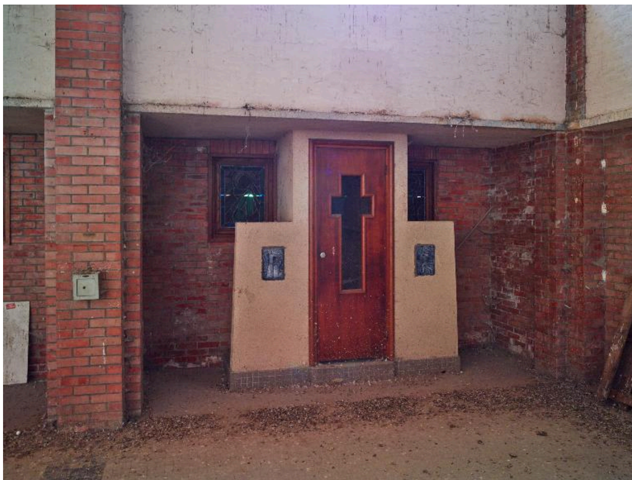
Vue du confessionnal côté droit, première travée.
