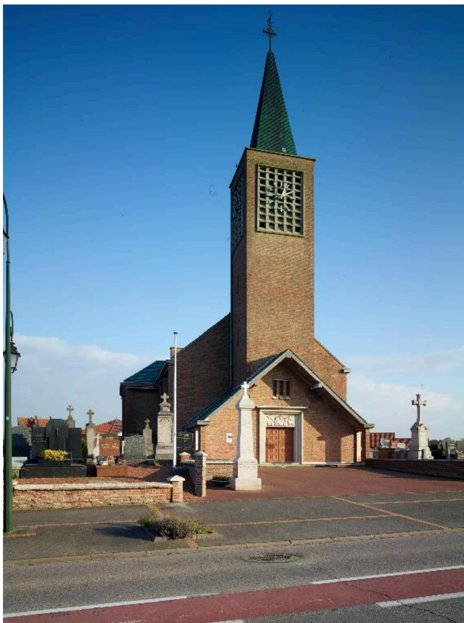
élévation antérieure de trois quart gauche
