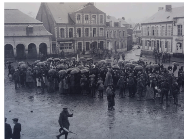
Sur cette photographie prise à la fin de la Première Guerre mondiale, la maison est visible à l'arrière plan (Fonds photographique du Musée Néo-zélandais, Le Quesnoy). Repro. Pierre Thibaut IVR32_20255900525NUCA
