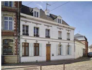
Vue de la façade et du mur qui clôture la propriété, percé de la porte qui donne accès à la remise. Phot. Pierre Thibaut IVR32_20235901082NUCA
