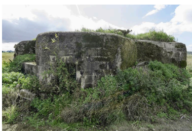
Vue de trois-quarts vers le sud-ouest. Entrée nord-est Phot. Jean-Marc Ramette IVR31_20145905113NUCA
