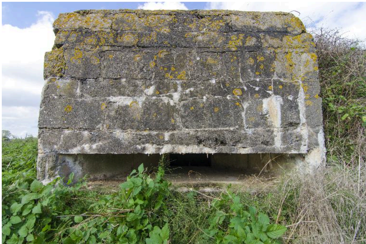
Embrasure de tir de la tourelle sud, vers le nord-ouest
