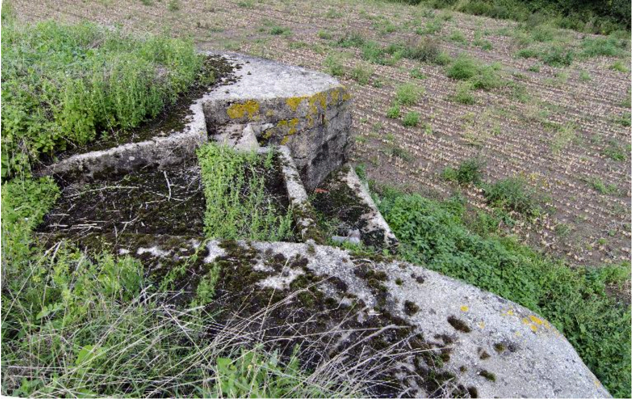
Depuis le couvrement, la cuve à mitrailleuse
