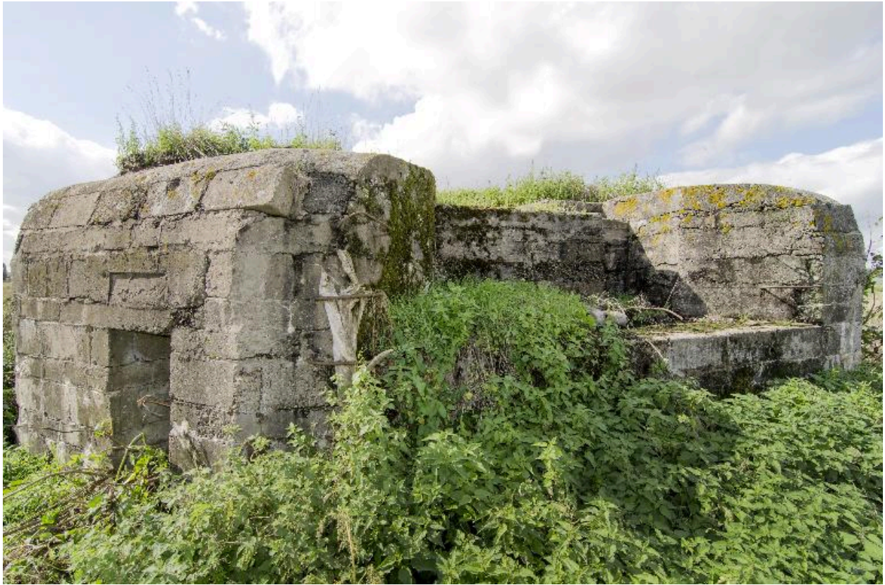
Vue de trois-quarts vers le nord-ouest. L'entrée sud-est, à gauche, la banquette de tir à droite
