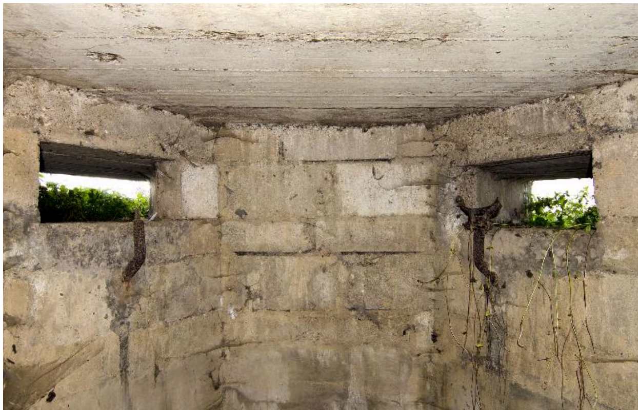
Vue intérieure de la tourelle sud
