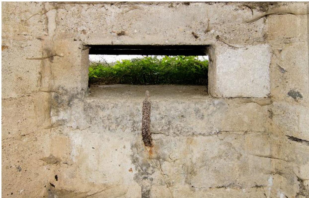
Tourelle sud. Embrasure de tir avec support de mitrailleuse
