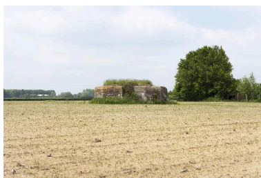
Vue générale, vers l'ouest Phot. Jean-Marc Ramette IVR31_20145905127NUCA
