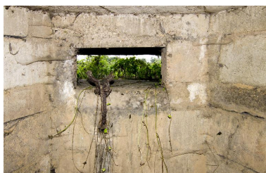
Tourelle sud. Embrasure de tir avec support de mitrailleuse Phot. Jean-Marc Ramette IVR31_20145905090NUCA
