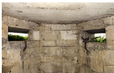
Vue intérieure de la tourelle sud Phot. Jean-Marc Ramette IVR31_20145905083NUCA
