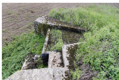
Depuis le couvrement, la banquette de tir et la cuve à mitrailleuse Phot. Jean-Marc Ramette IVR31_20145905093NUCA
