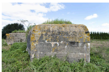
Vue latérale, vers le nord. Phot. Jean-Marc Ramette IVR31_20145905107NUCA
