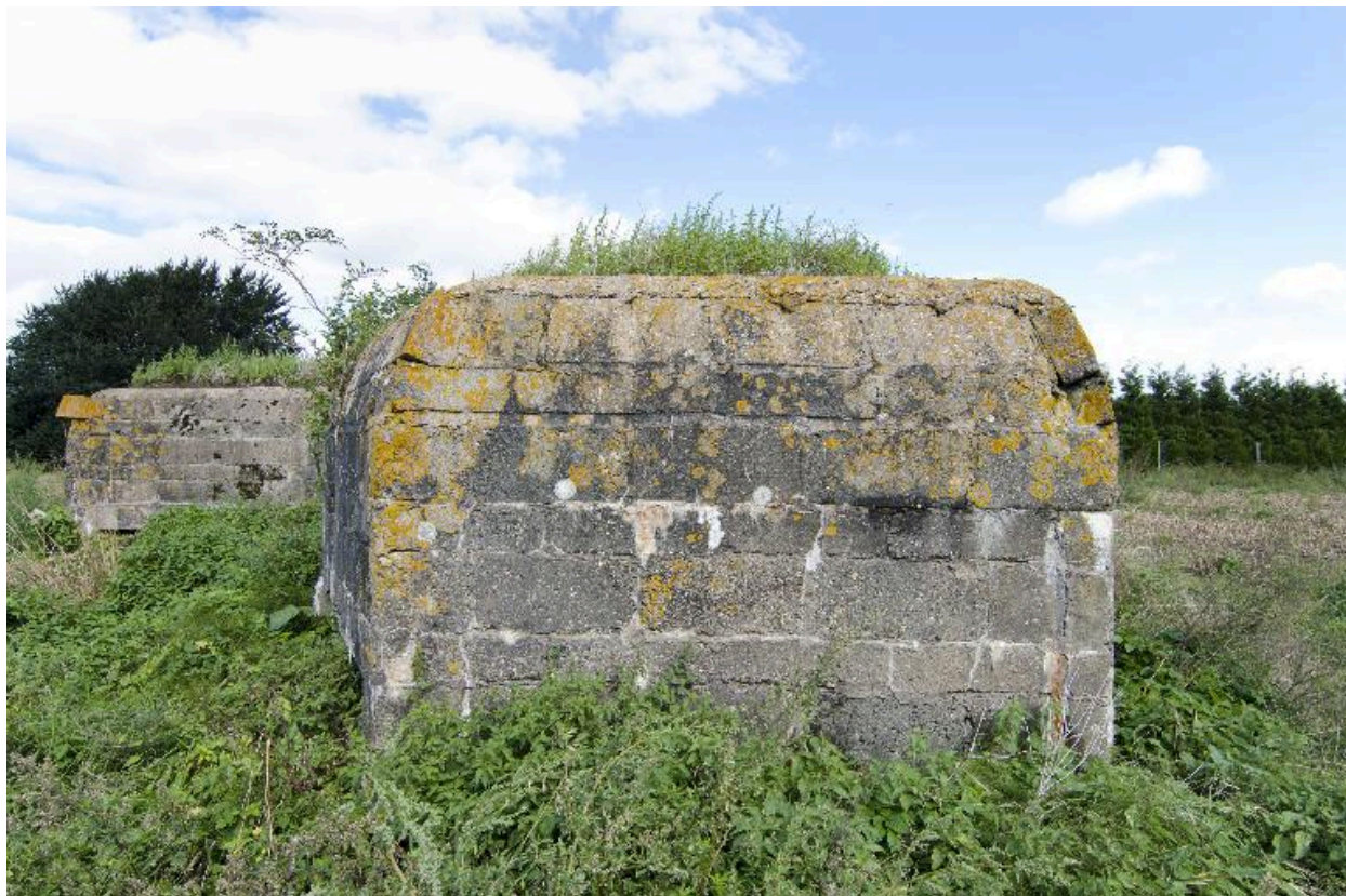
Vue latérale, vers le nord.
