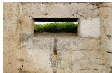
Tourelle sud. Embrasure de tir avec support de mitrailleuse Phot. Jean-Marc Ramette IVR31_20145905091NUCA
