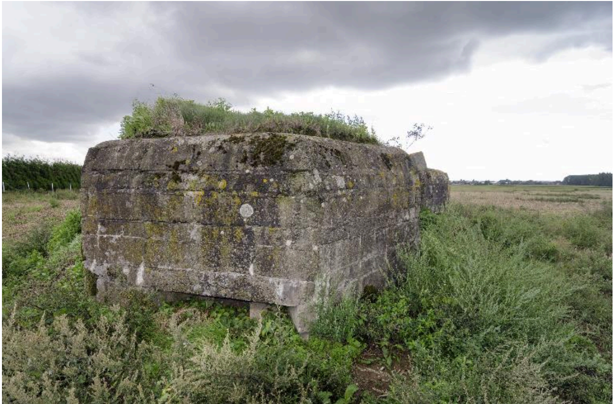
Tourelle nord, vers le sud-est
