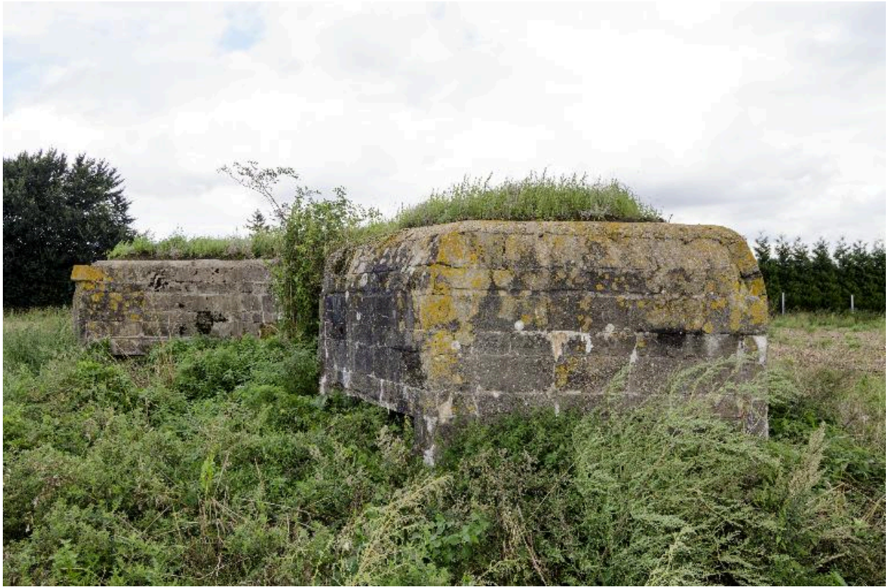
Vue vers le nord. A gauche la tourelle sud. A droite, la tourelle nord
