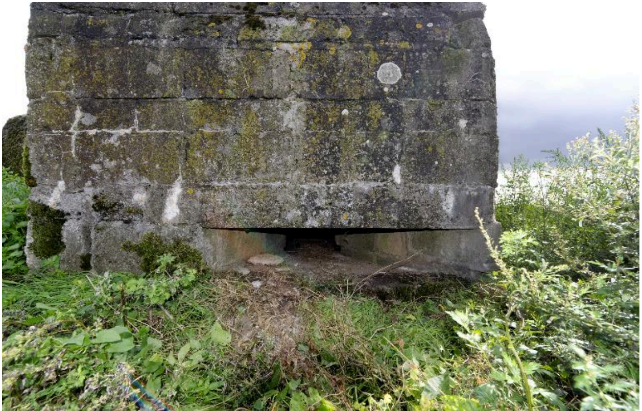
Embrasure de tir de la tourelle nord
