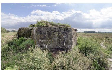
Embrasure de tir, vue latérale vers le sud Phot. Jean-Marc Ramette IVR31_20145905122NUCA
