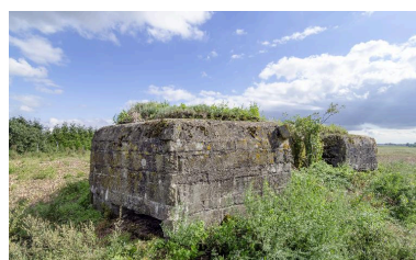
Vue de trois-quarts vers le sud-est Phot. Jean-Marc Ramette IVR31_20145905121NUCA
