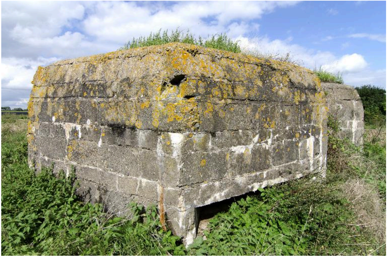
Embrasure de tir de la tourelle sud, vers le nord (au grand angulaire)
