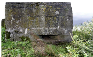
Embrasure de tir de la tourelle nord Phot. Jean-Marc Ramette IVR31_20145905102NUCA
