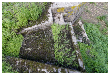
Depuis le couvrement, la cuve à mitrailleuse, le logement d'un des deux servants, au centre, et la banquette de tir, à droite Phot. Jean-Marc Ramette IVR31_20145905101NUCA
