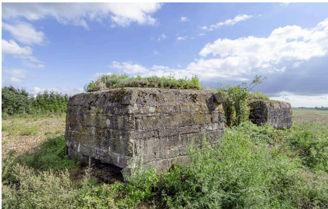
Vue de trois-quarts vers le sud-est
