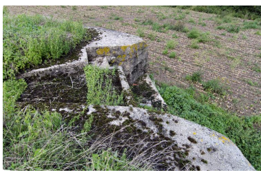
Depuis le couvrement, la cuve à mitrailleuse Phot. Jean-Marc Ramette IVR31_20145905100NUCA
