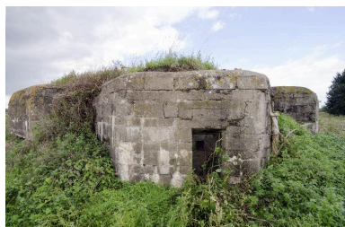
Vue de trois-quarts, vers nord-ouest. Entrée sud-est Phot. Jean-Marc Ramette IVR31_20145905082NUCA
