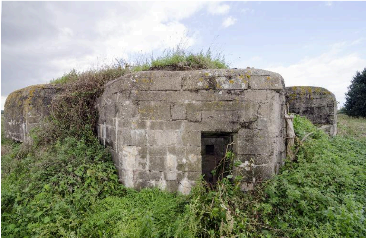
Vue de trois-quarts, vers nord-ouest. Entrée sud-est
