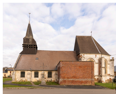
Vue de l'élévation sud. Phot. Marc Kérignard IVR32_20246000046NUCA
