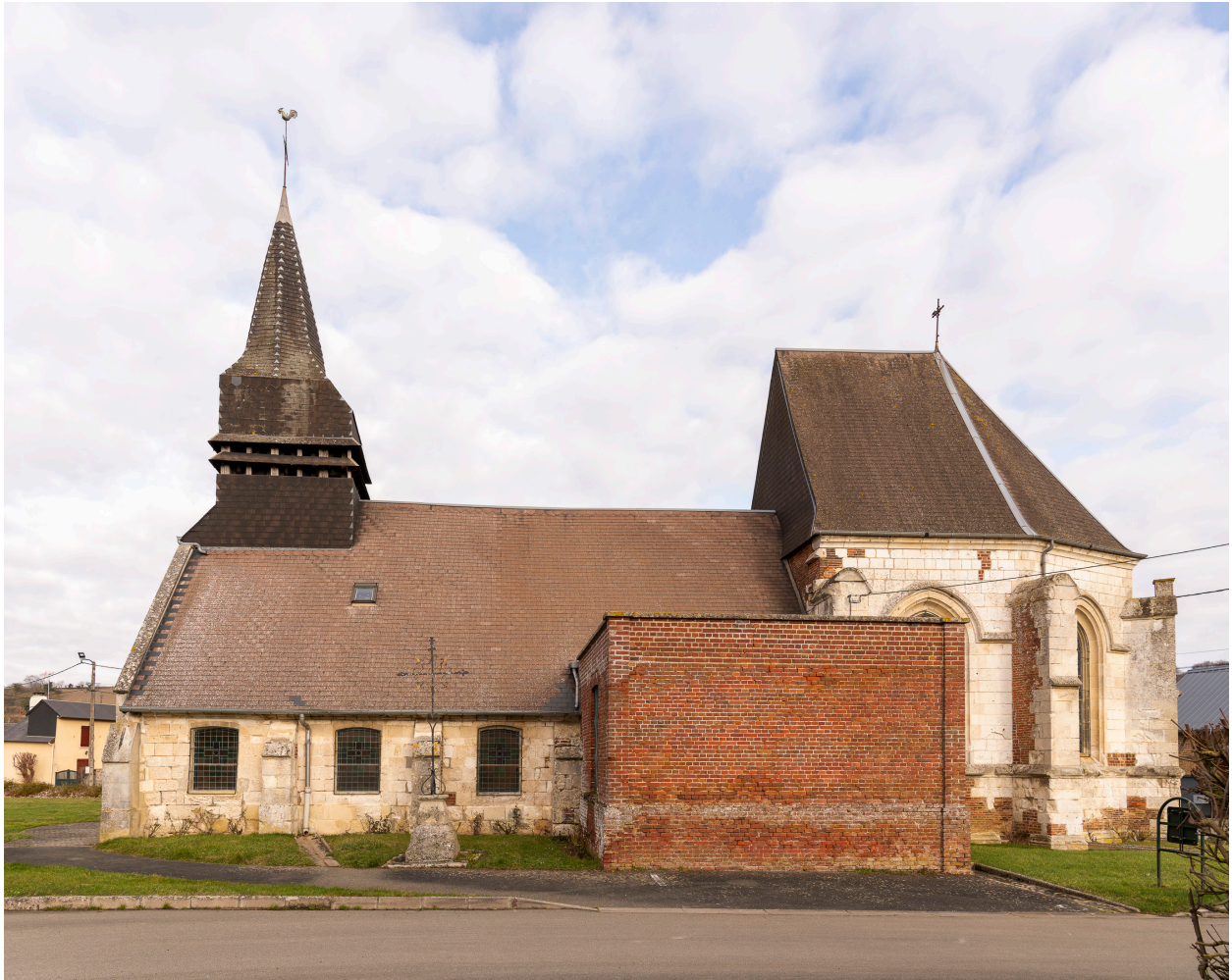
Vue de l'élévation sud.
