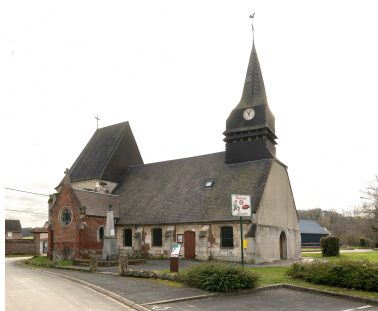
Vue générale depuis le nord-ouest. Phot. Marc Kérignard IVR32_20246000050NUCA
