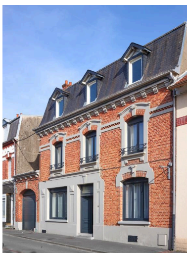
Ancienne maison-boucherie de M. Duquesne-Cottel, 19 place Faidherbe. Construite par Eugène Bidard en septembre 1921. (AD Pas-de-Calais, 10R9/43, dossier n°639). (voir IA62005183). Phot. Hubert Bouvet IVR32_20196200474NUCA
