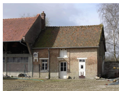
Vue du bâtiment sud.
