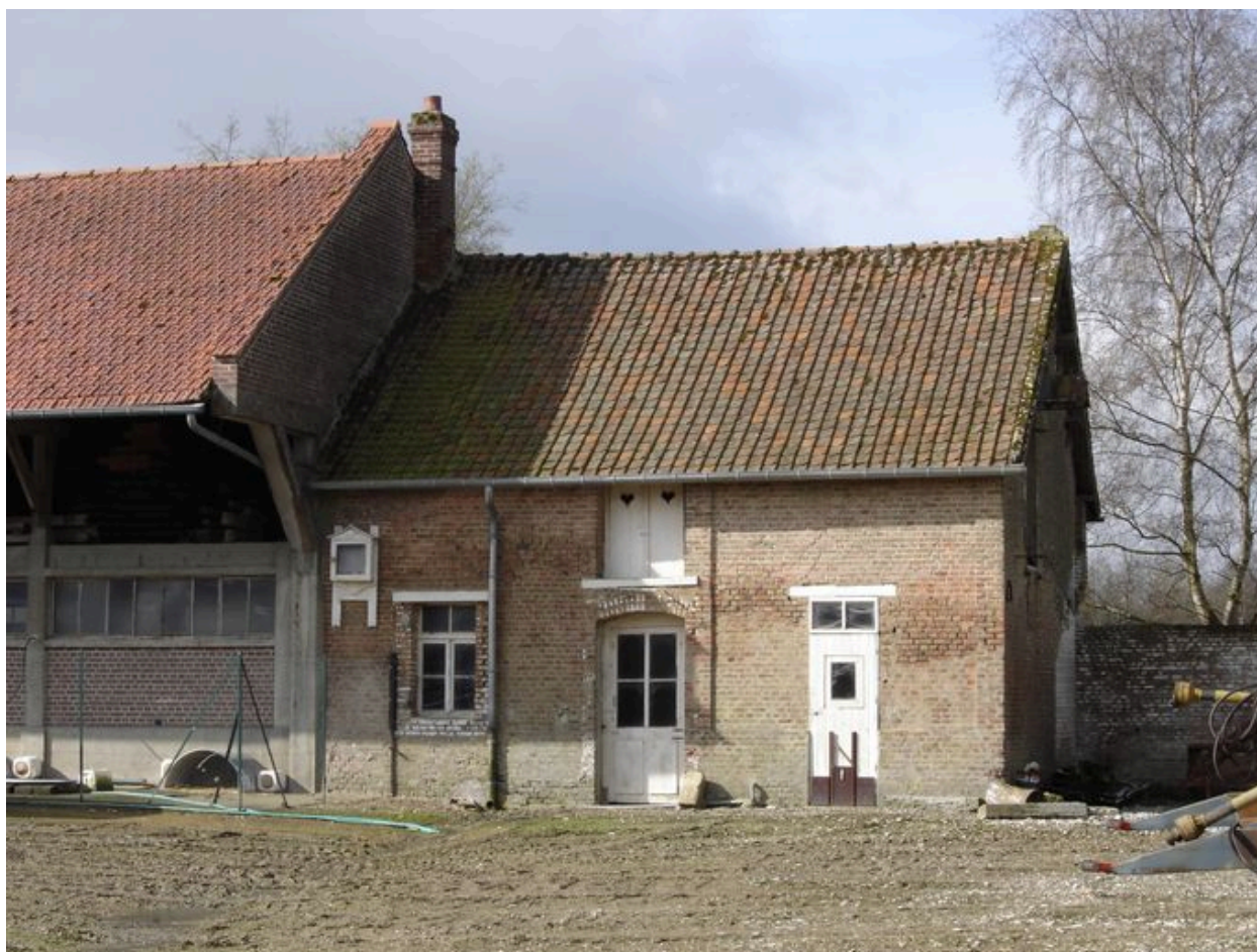
Vue du bâtiment sud.
