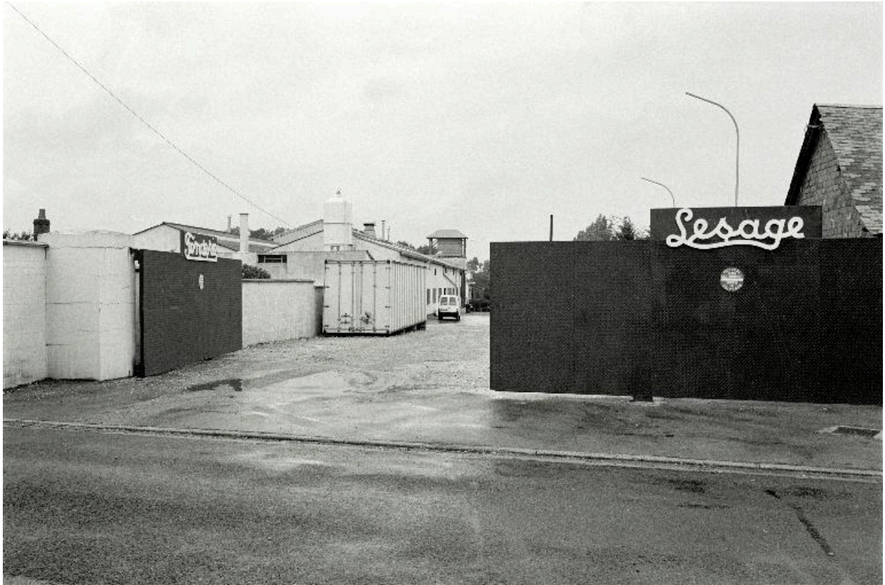
Vue de l'entrée du site en 1990.
