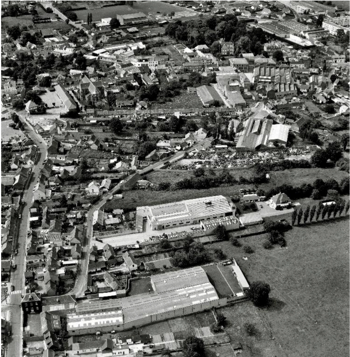
Vue aérienne de l'ancienne fonderie Lesage en 1988.
