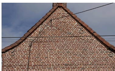
Détail du pignon portant la date 1833. Phot. Pierre Thibaut IVR31_20095903233NUCA
