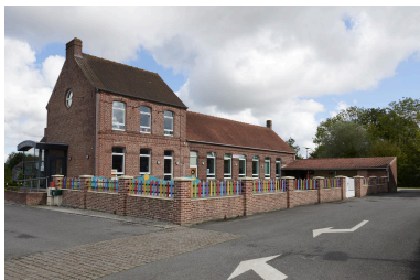
Pignon ouest et façade sud sur cour. Phot. Delphine Volto Jourdan IVR32_20245902983NUCA
