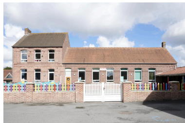
Façade sud, sur cour. Phot. Delphine Volto Jourdan IVR32_20245902981NUCA
