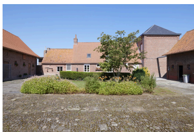
Cour intérieure, logis en arrière-plan. Phot. Delphine Volto Jourdan IVR32_20245902717NUCA
