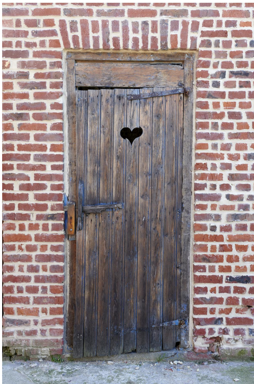
Porte en bois, pignon du bâtiment agricole sud.
