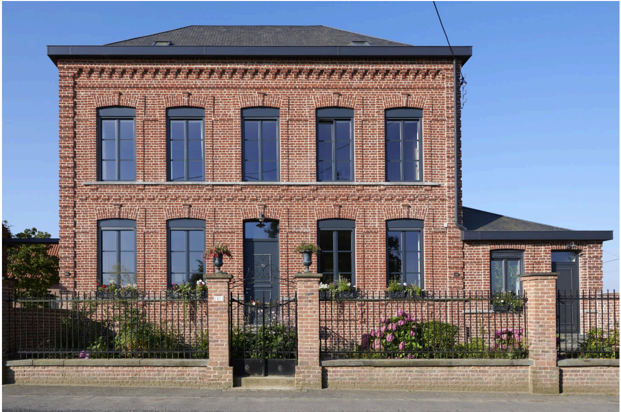
Façade sur rue du logis principal.
