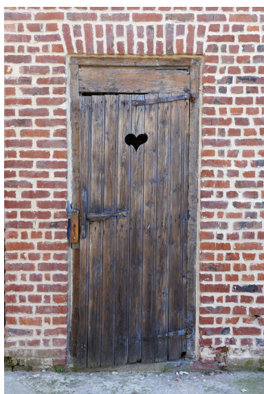
Porte en bois, pignon du bâtiment agricole sud. Phot. Delphine Volto Jourdan
