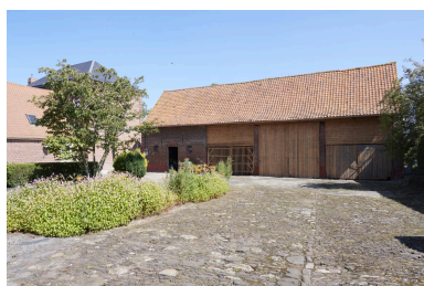
Façade sur cour du bâtiment agricole nord. Phot. Delphine Volto Jourdan IVR32_20245902716NUCA
