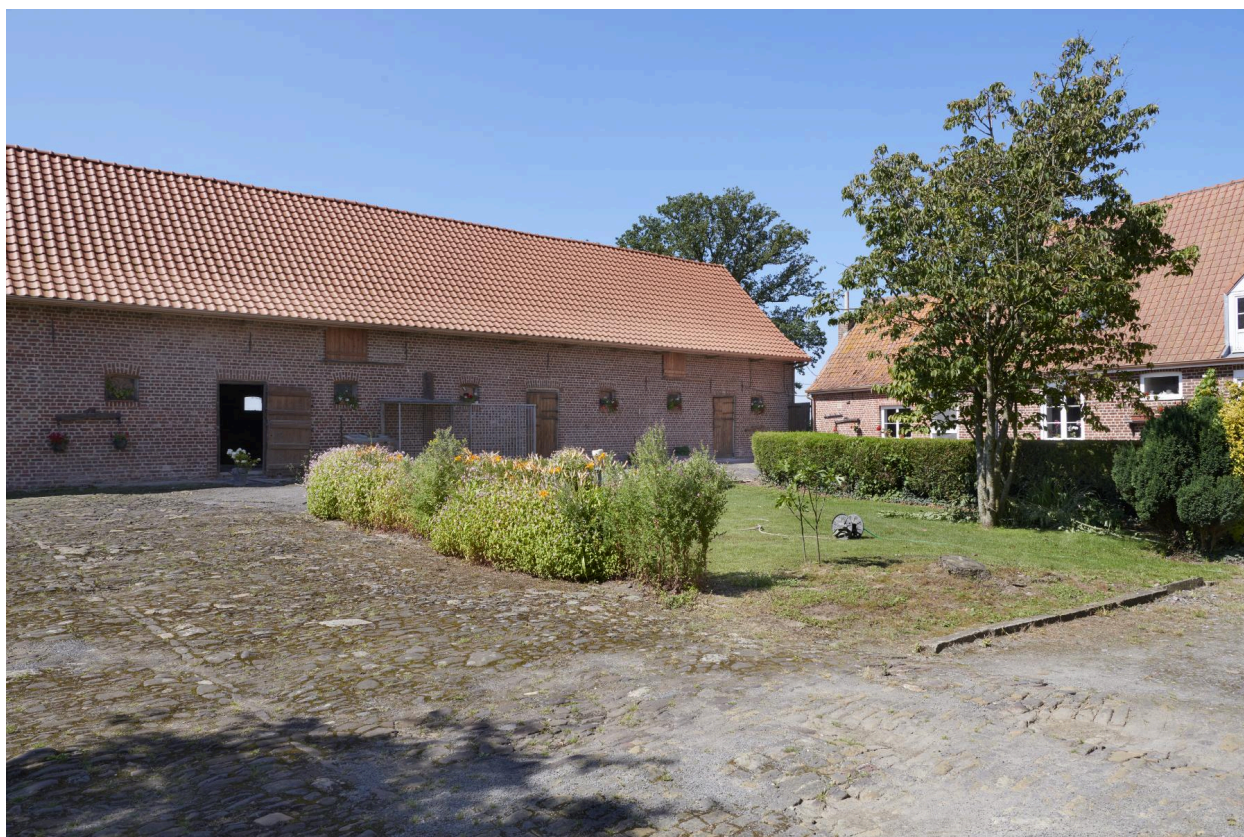
Bâtiment agricole sud, façade sur cour.
