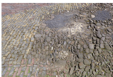
Détail du pavage hétérogène de la cour avec grès de Cassel, briques jaunes et rouges. Phot. Delphine Volto Jourdan IVR32_20245902715NUCA
