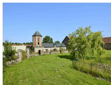
Pigeonnier et chenil de la ferme, vus depuis le logement de la ferme. Phot. Thierry Lefébure IVR32_20258001196NUCA
