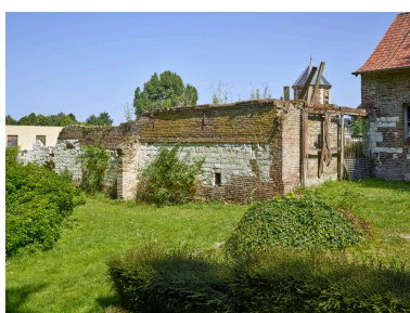
Mur de clôture ouest de la ferme et vue partielle du logement à droite. Phot. Thierry Lefébure IVR32_20258001203NUCA
