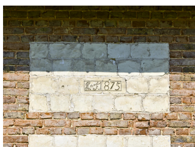
Magasin à fourrage, détail des initiales et de la date de 1875 situées au-dessus de l'entrée. Phot. Thierry Lefébure IVR32_20258001201NUCA
