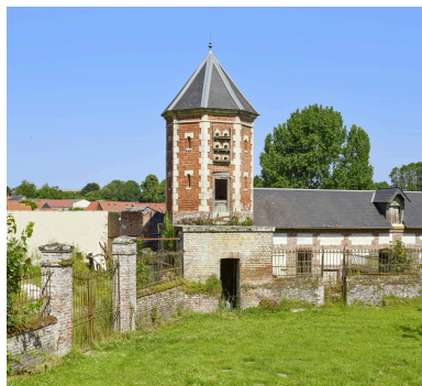
Pigeonnier de la ferme, avec à gauche le portail d'entrée à la basse-cour, et à droite, le chenil. Phot. Thierry Lefébure IVR32_20258001198NUCA
