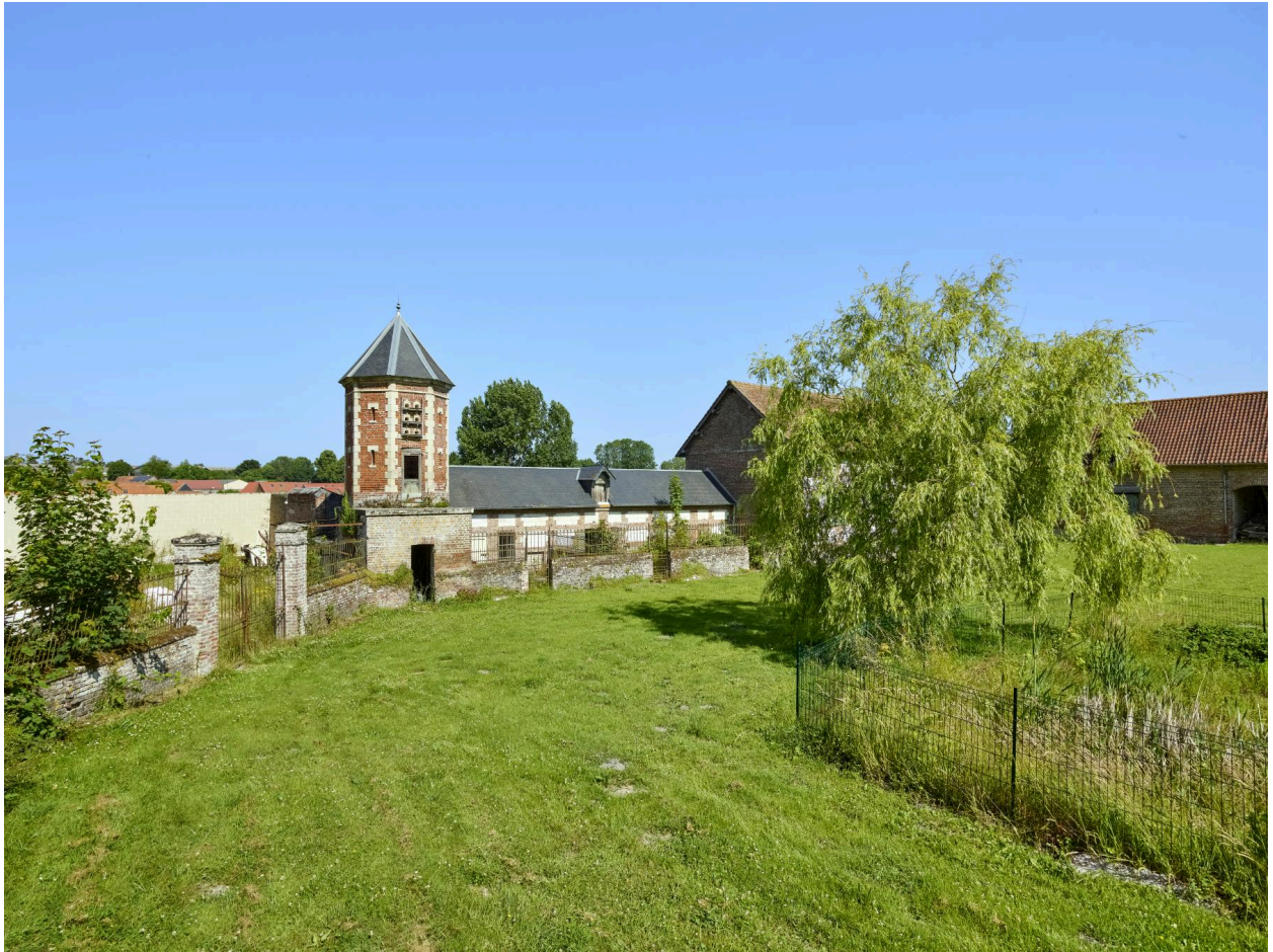
Pigeonnier et chenil de la ferme, vus depuis le logement de la ferme.
