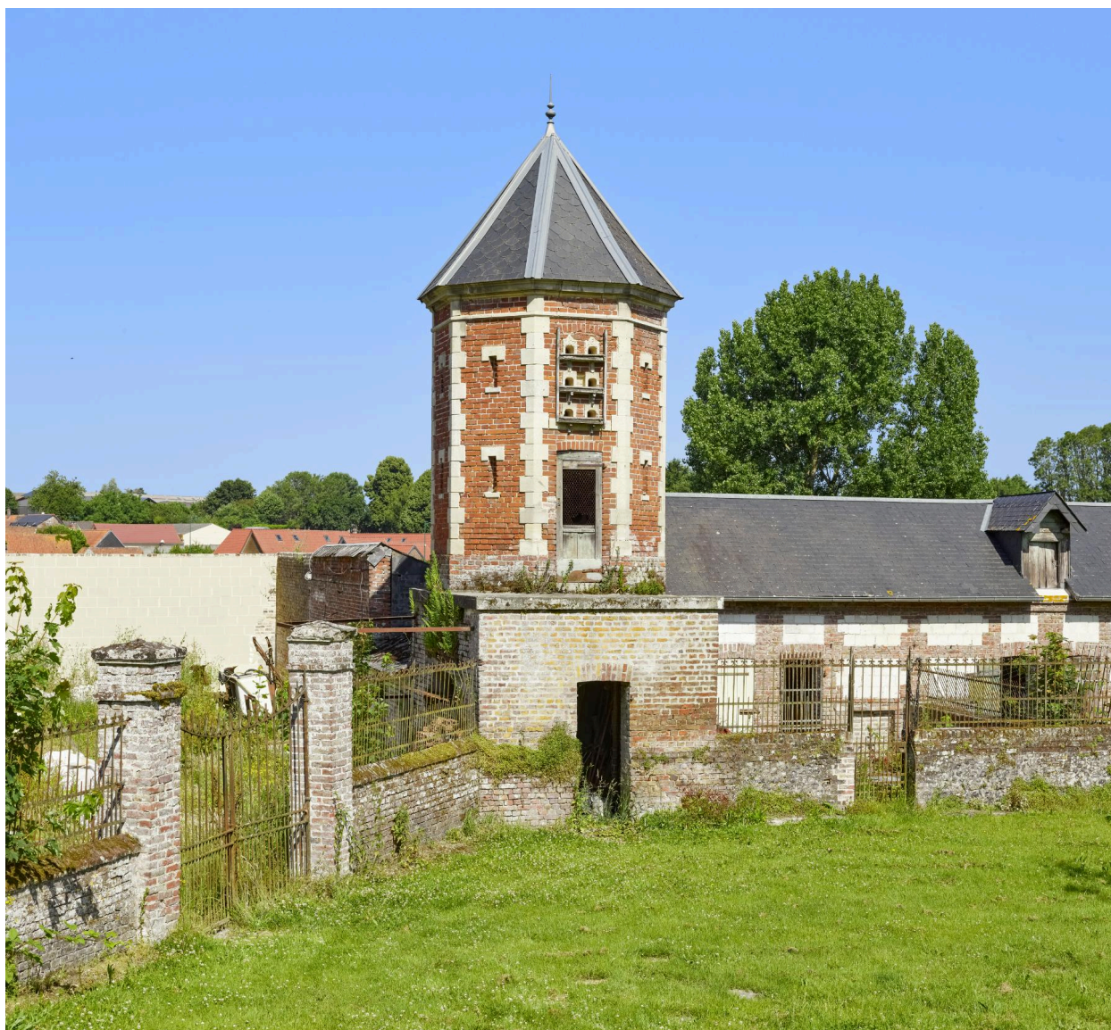
Pigeonnier de la ferme, avec à gauche le portail d'entrée à la basse-cour, et à droite, le chenil.
