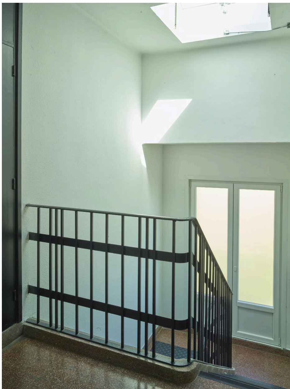
Détail de la rampe en fer forgé sur le dernier palier.
