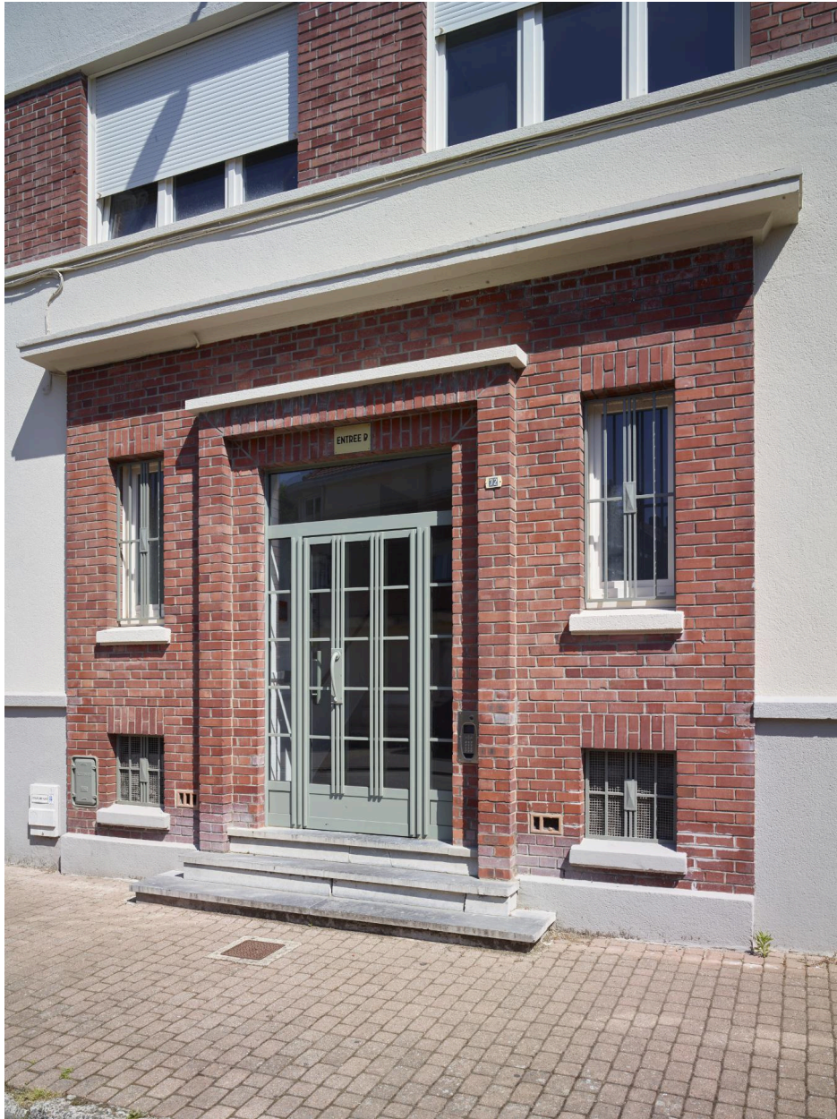
Détail de la porte d'entrée du n°72.
