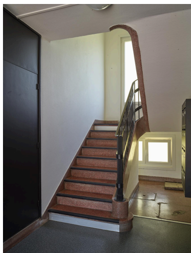
Palier du premier niveau, escalier en granito et départ de rampe en fer forgé de style moderne. Phot. Pierre Thibaut IVR32_20255900511NUCA
