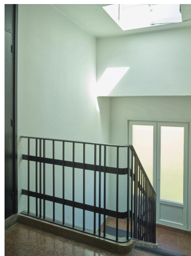
Détail de la rampe en fer forgé sur le dernier palier. Phot. Pierre Thibaut IVR32_20255900513NUCA
