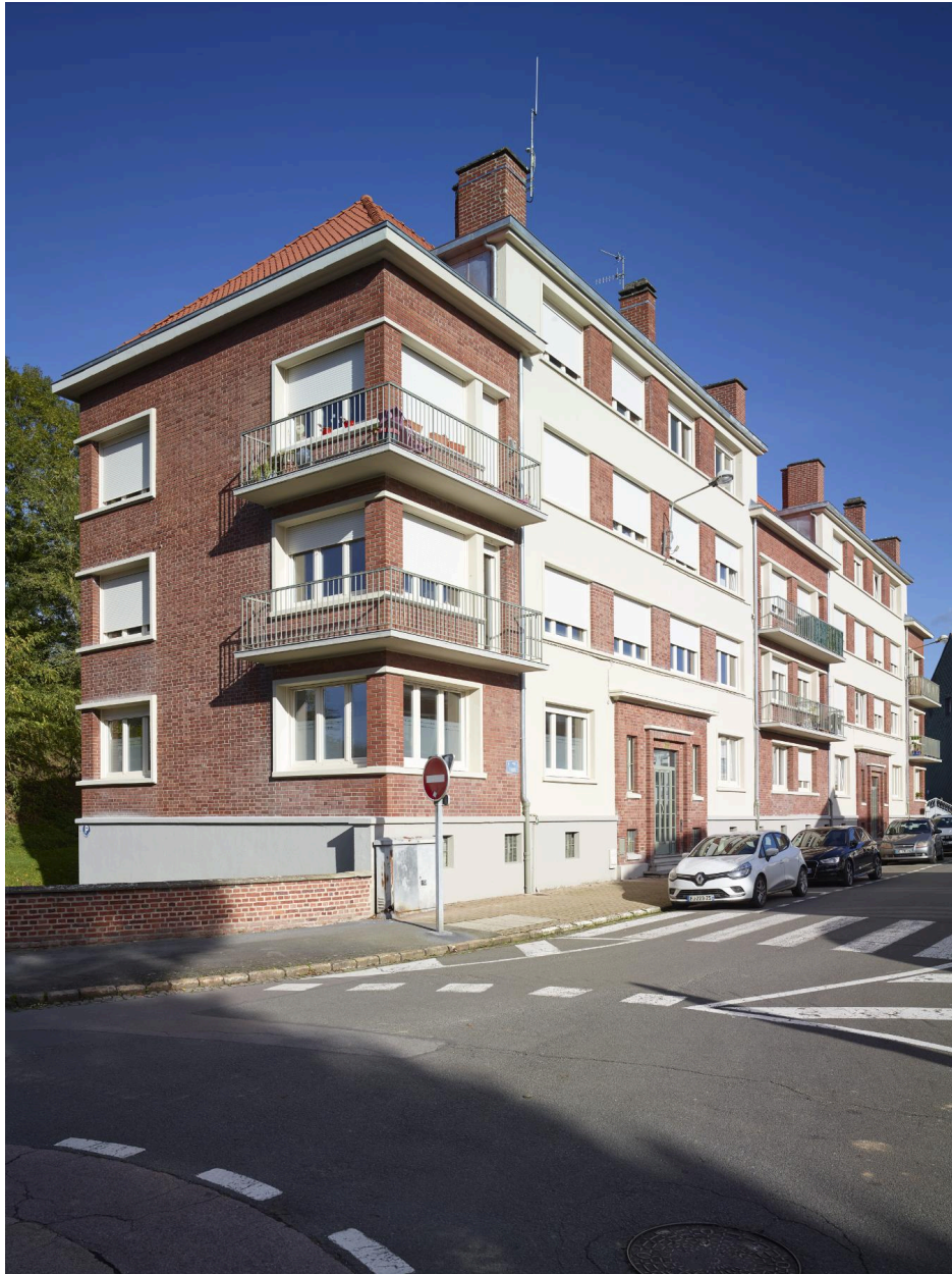
Vue générale de la façade orientée ouest/est.
