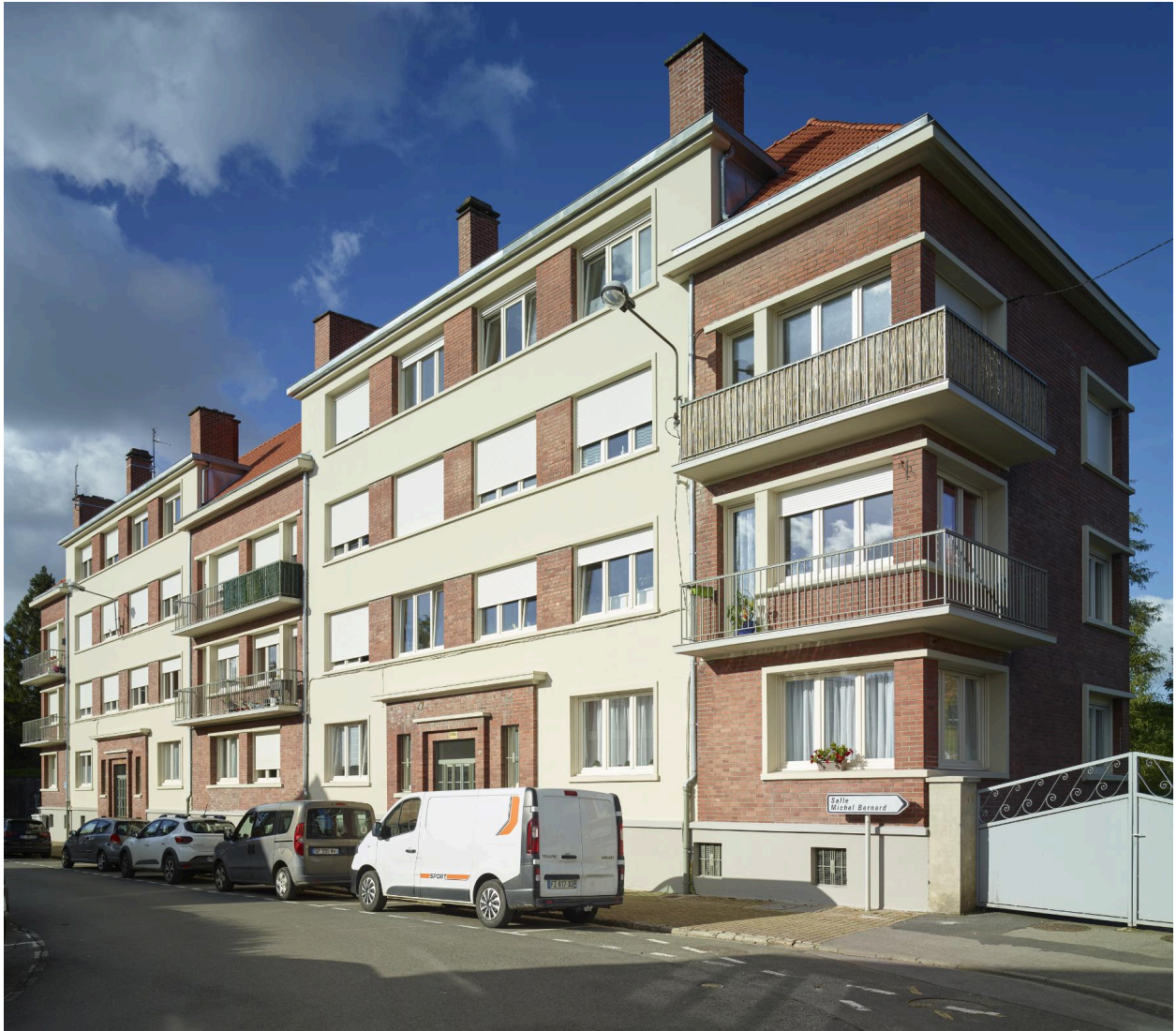
Vue générale de la façade principale orientée est/ouest.
