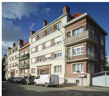
Vue générale de la façade principale orientée est/ouest. Phot. Pierre Thibaut IVR32_20245902544NUCA
