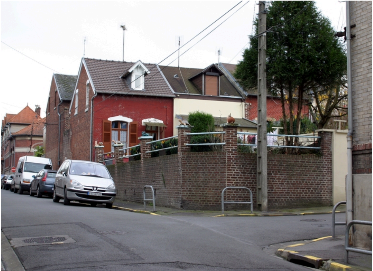
Les deux rangées de logements, à l'angle des rues de Picardie et d'Amiens.
