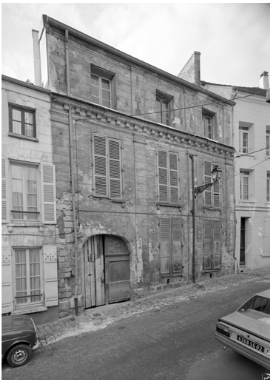
Vue de la façade sur la rue.
