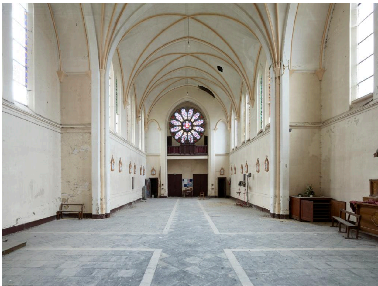
Vue intérieure vers la façade occidentale.
