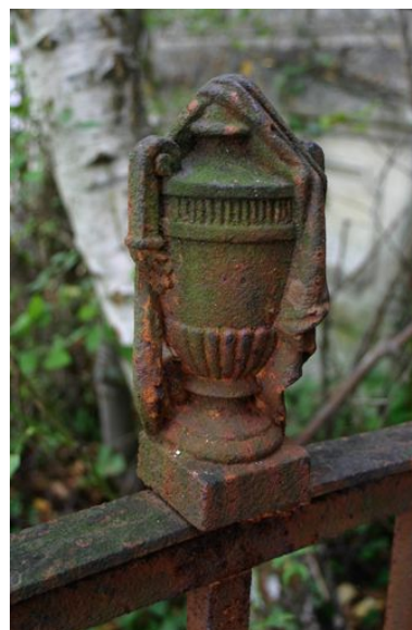
Détail d'une urne voilée, ornant la grille de clôture. Phot. Caroline Vincent IVR22_20078000434NUCA
