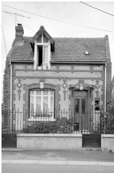
Elévation antérieure. Phot. Jean-Michel Perrin IVR22_19856000947X
