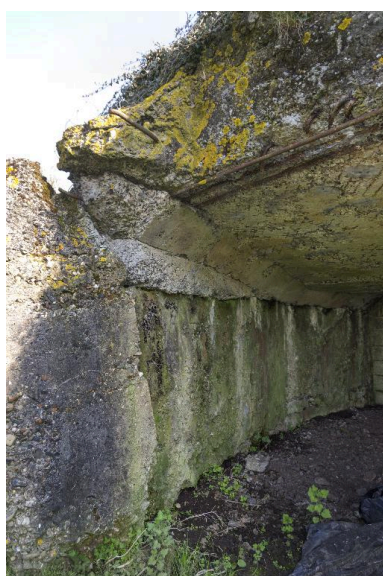
Chambre de tir, détail de la jonction du couvrement avec le mur nord-est Phot. Jean-Marc Ramette IVR32_20165900997NUC
