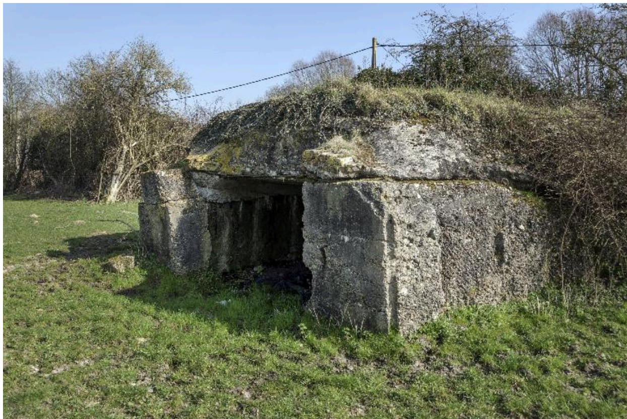
Sortie de la chambre de tir, vers l'est
