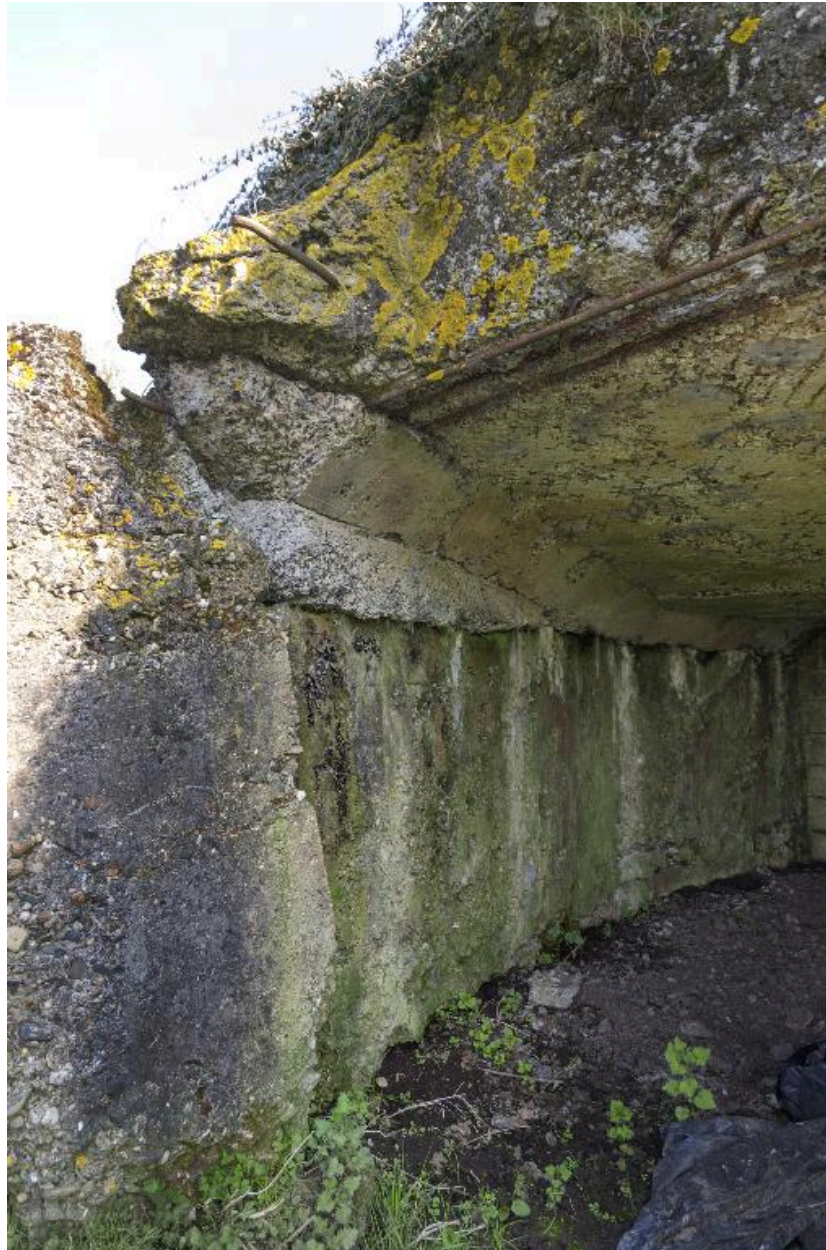
Chambre de tir, détail de la jonction du couvrement avec le mur nord-est
