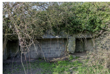
Élévation sud-est. L'accès à la chambre de tir (au centre) et les accès latéraux (magasin à munition, abri du personnel) ont été murés Phot. Jean-Marc Ramette IVR32_20165900998NUC
