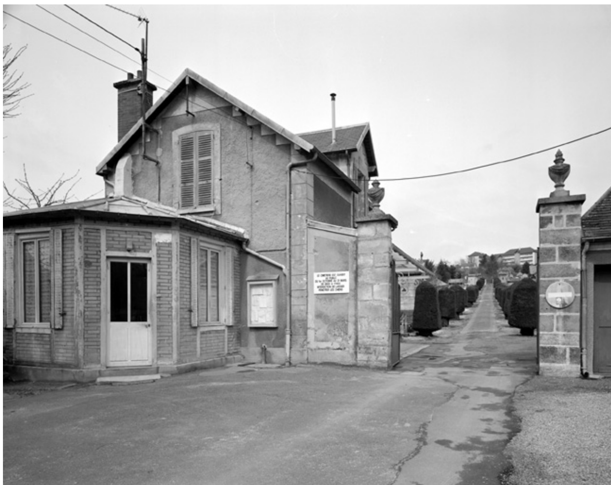
Portail et pavillon d'entrée.
