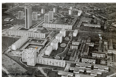
Vue aérienne du grand ensemble des Oliveaux depuis le sud, vers 1975 (AC Loos-les-Lille ; 1 Fi 867).
