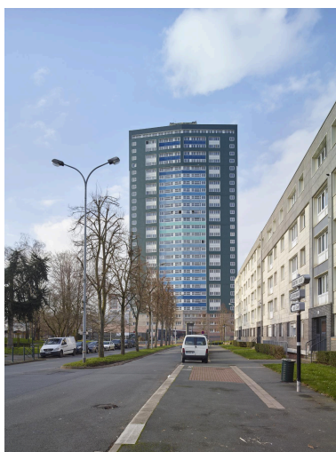
La façade Est, depuis la rue Vincent-Auriol. Phot. Pierre Thibaut IVR32_20245900100NUCA
