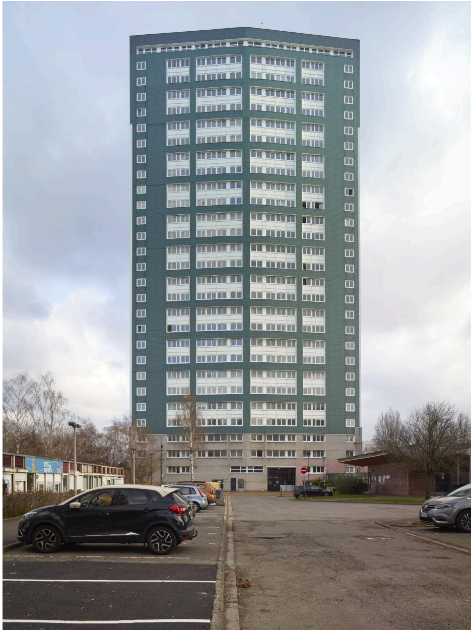
La façade ouest, depuis la place du Général-De-Gaulle.
