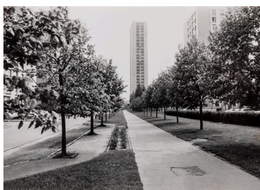
La façade nord de la tour Kennedy depuis la rue de la Paix, fin des années 1970 (AC Loos-les-Lille ; 1 Fi 850).
