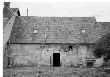
Elévation postérieure. Phot. Jean-Michel Perrin IVR22_19856000750X
