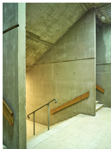
Détail des escaliers intérieurs : le béton est laissé brut. Phot. Pierre Thibaut IVR32_20195900076NUCA
