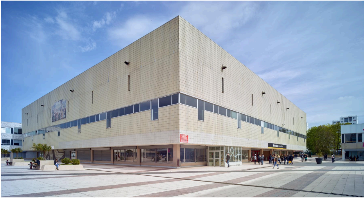
Vue d'ensemble depuis l'angle nord-ouest de l'édifice.
