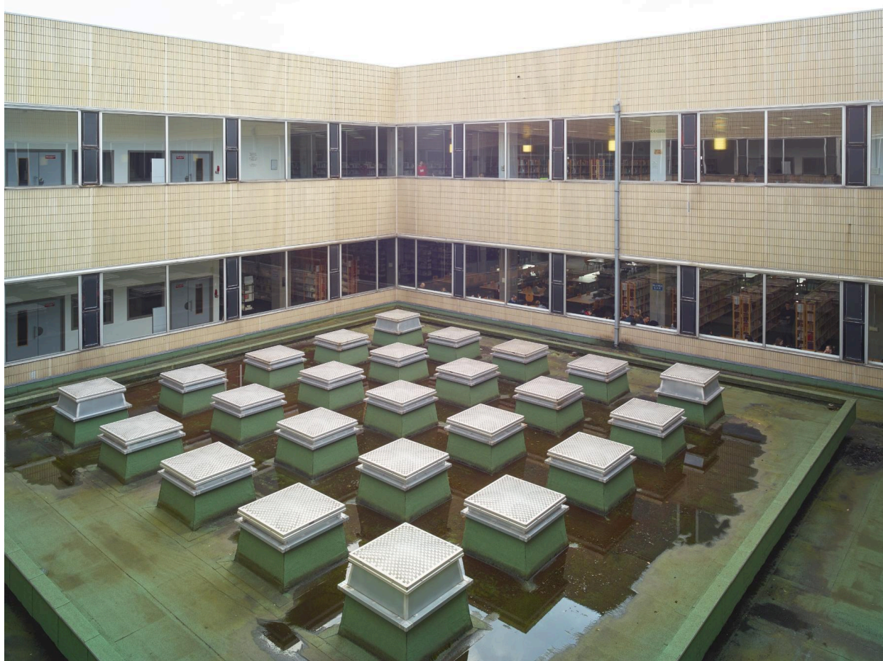
Vue des salles de travail sur le patio, qui éclaire le hall d'entrée, situé au-dessous.
