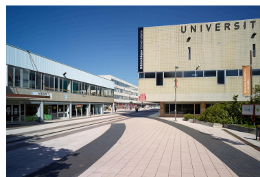
Vue de la bibliothèque depuis l'entrée sur le campus. Phot. Pierre Thibaut IVR32_20195900053NUCA
