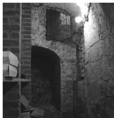
Sous-sol, vue partielle : mur de la façade.
