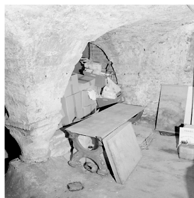
Sous-sol, vue partielle : cave médiévale, colonnes et voûtement. Phot. Pierre Thibaut IVR31_20055901146X
