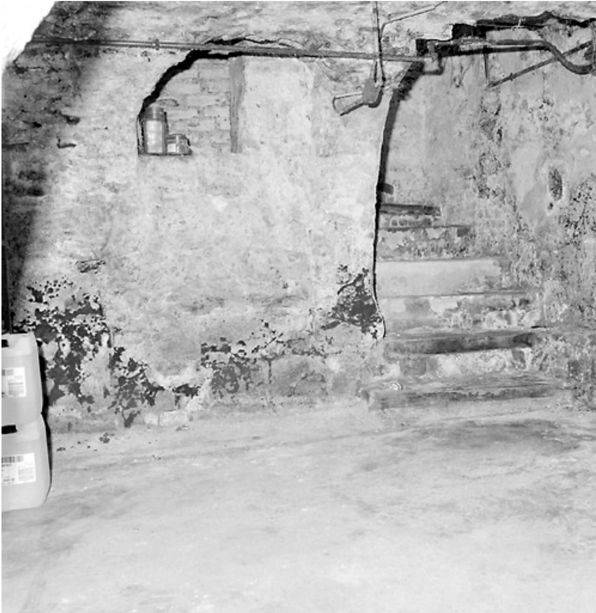
Sous-sol, vue partielle : cave médiévale, escalier d'accès actuel.
