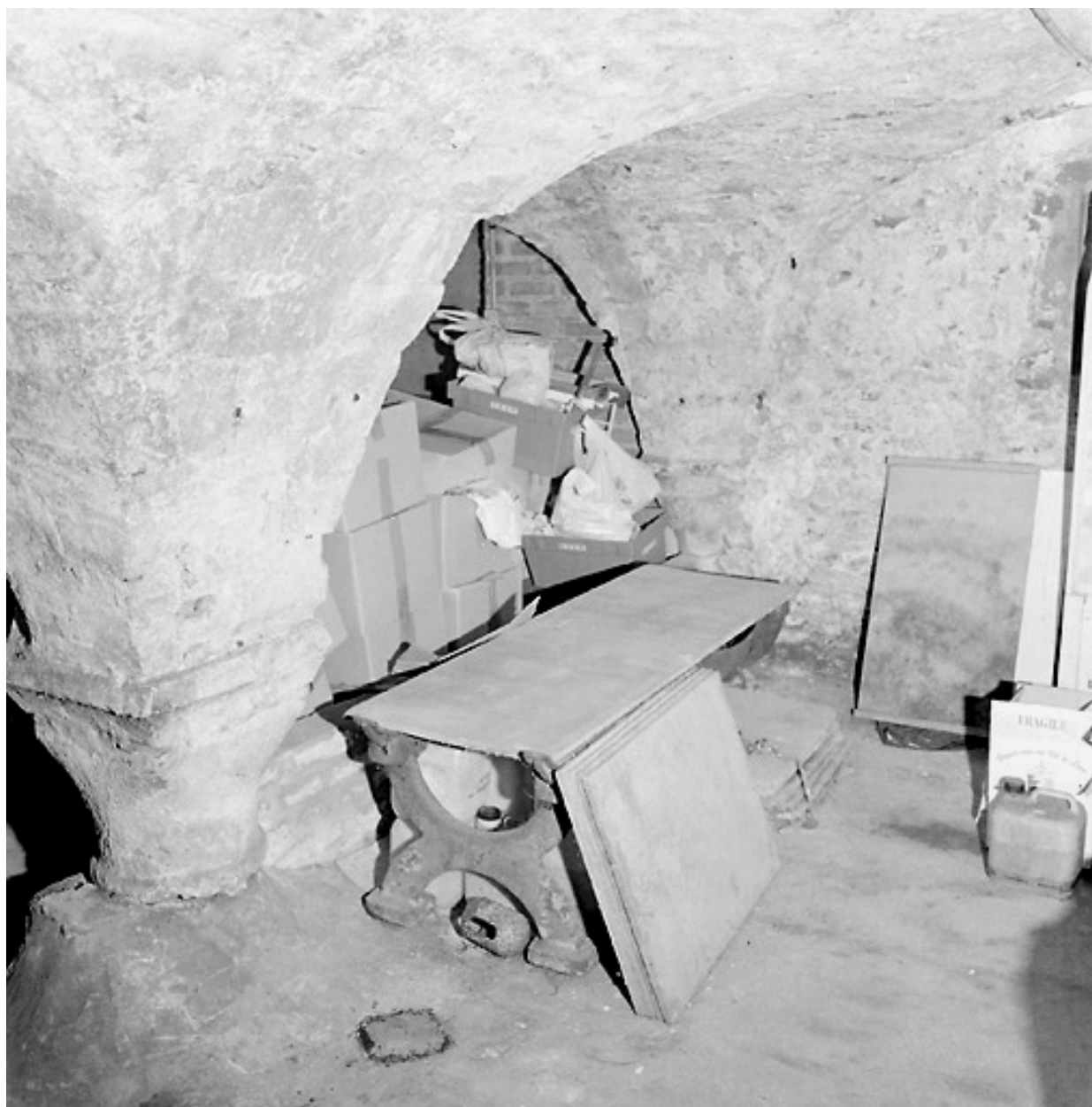
Sous-sol, vue partielle : cave médiévale, colonnes et voûtement.
