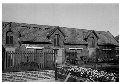
Etable à chevaux en 1990. Phot. Francis Dubuc IVR22_19908001281Z
