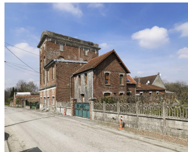
Vue d'ensemble sur rue de la brasserie. Phot. Thierry Lefébure IVR22_20158000160NUC2A
