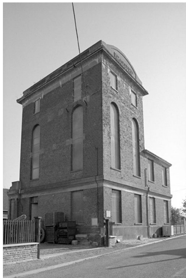
Atelier de fabrication, vue générale en 1990 Phot. Francis Dubuc IVR22_19908001283Z
