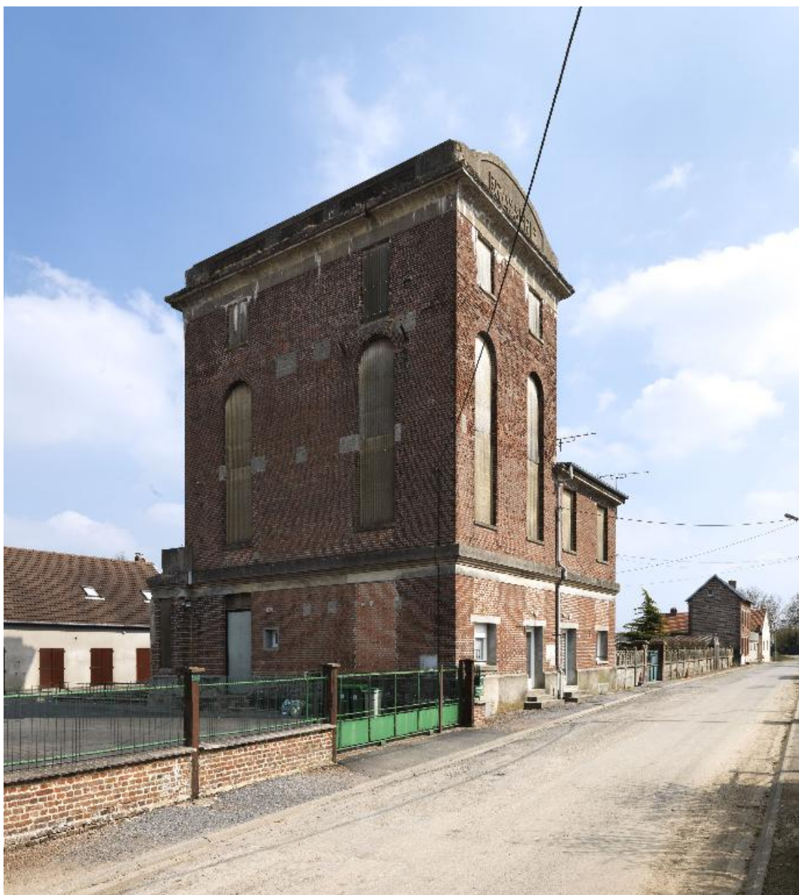
Vue d'ensemble côté nord.
